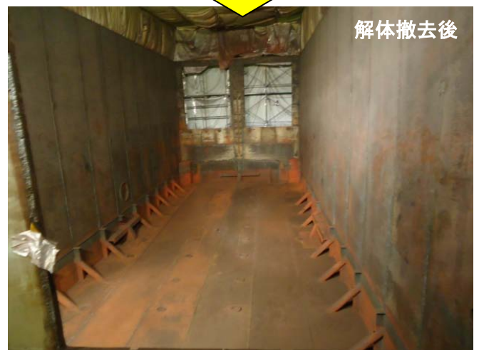
B 復水器内部構造物（冷却管）の解体撤去状況 ：タービン建屋（管理区域）地下2階
