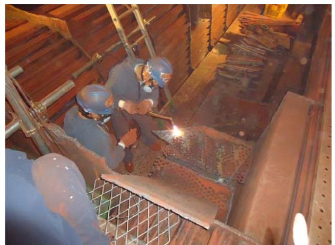
B復水器冷却管解体作業の状況
