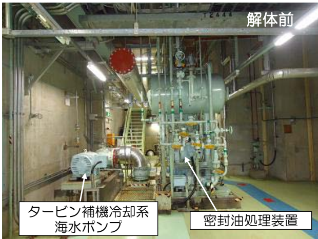
密封油処理装置等の解体状況（解体前後）：タービン建屋（非管理区域）地下2階
