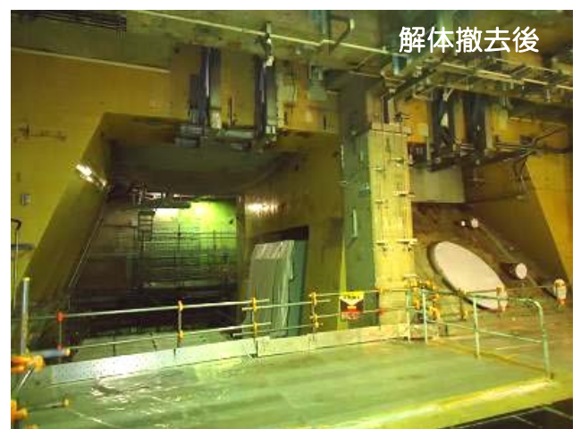
復水器等の解体撤去状況（解体撤去前後）：タービン建屋（管理区域）地下 1 階
