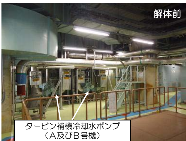
タービン補機冷却水ポンプ等の解体状況（解体前後）：タービン建屋（非管理区域）地下 1 階
