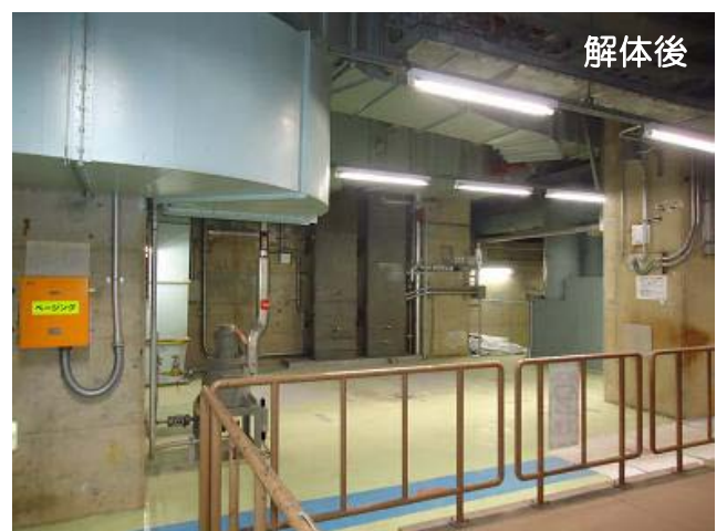
タービン補機冷却水ポンプ等の解体状況（解体前後）：タービン建屋（非管理区域）地下 1 階
