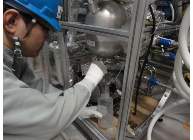
除湿機で回収したドレン水量の確認状況
