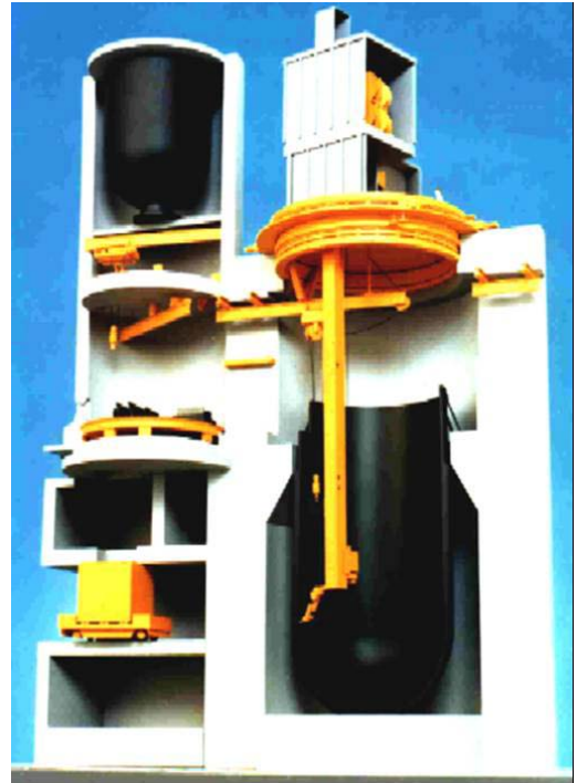
WAGR 原子炉及びRDM モデル
