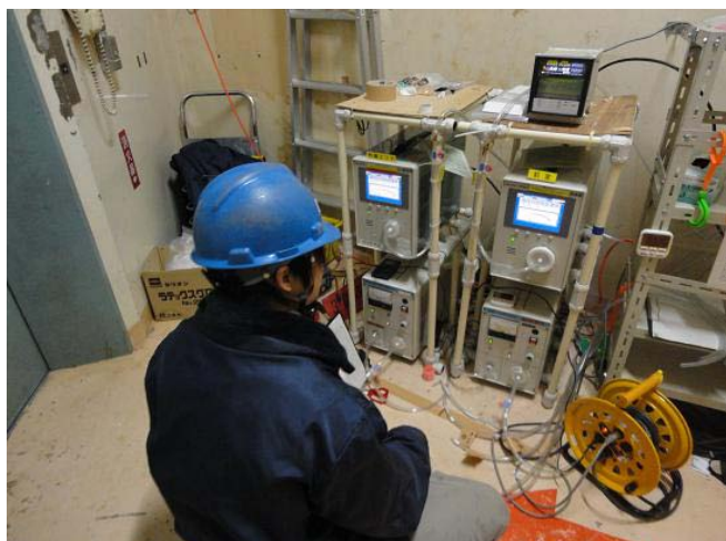
汚染の除去工事状況（ガスマニタによる作業エリアのトリチウム濃度監視）
