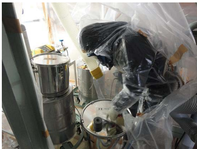
汚染の除去工事状況（二次廃棄物の収容作業）
