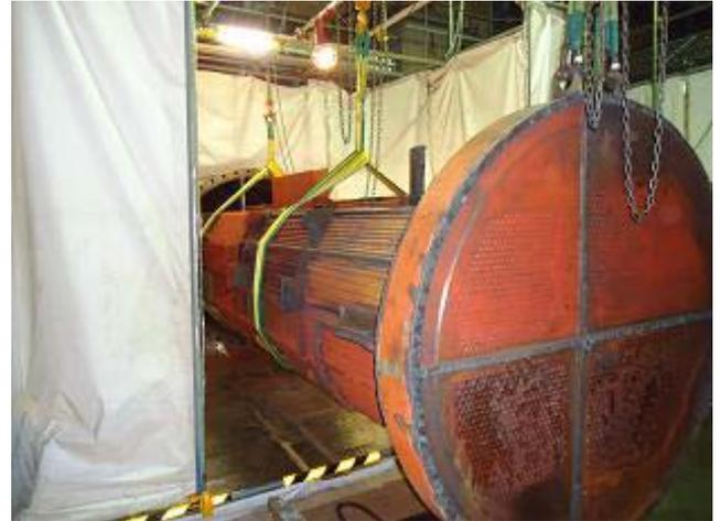
第1・第2給水加熱器解体撤去(伝熱管部の引き出し)状況
