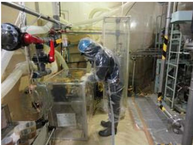
汚染の除去工事（残留重水の回収）状況
