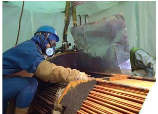
第1・第2給水加熱器解体撤去(伝熱管の切断)状況
