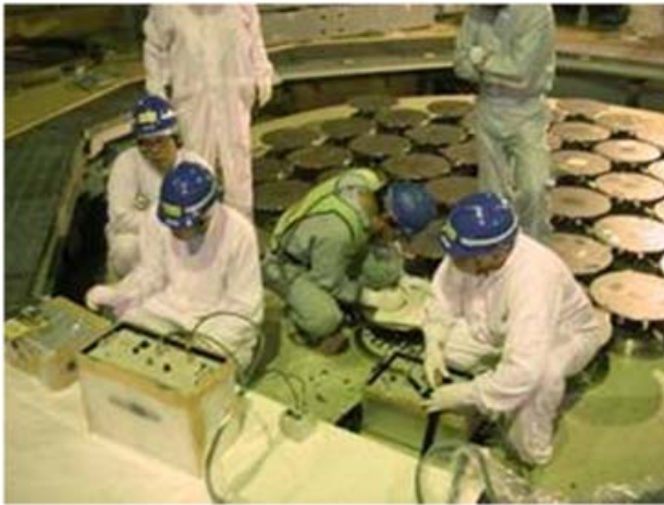
ケーブル劣化診断法の適用試験
