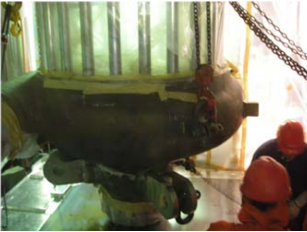
再循環ポンプケーシング試料の採取
