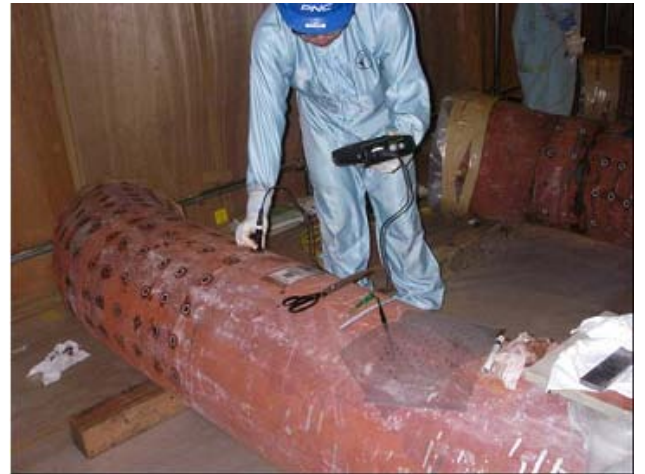
タービン系炭素鋼配管の厚さ測定
