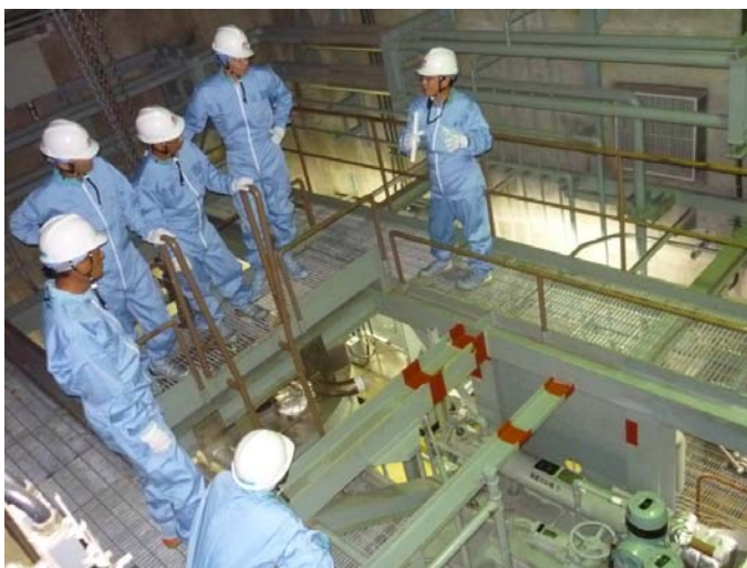
浜岡原子力発電所2号機可燃性ガス濃度制御系後置冷却器の取外し状況
