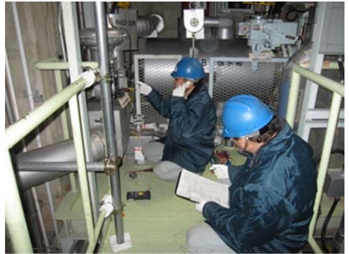
廃棄物処理系制御弁の点検校正
