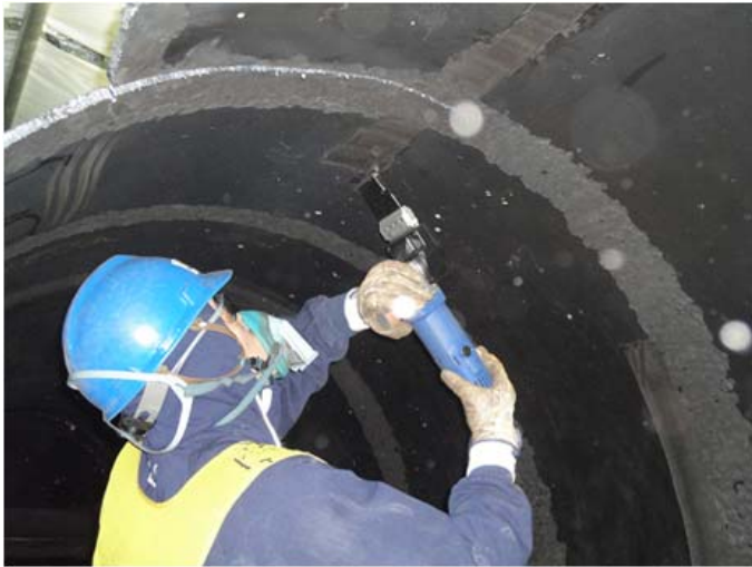
海水配管内保護塗料剥離除去作業
