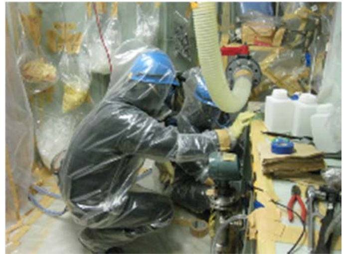
残留重水回収作業
