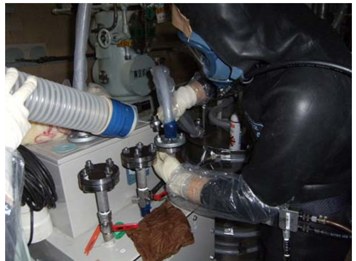
トリチウム除去対象箇所への真空ポンプ接続作業
