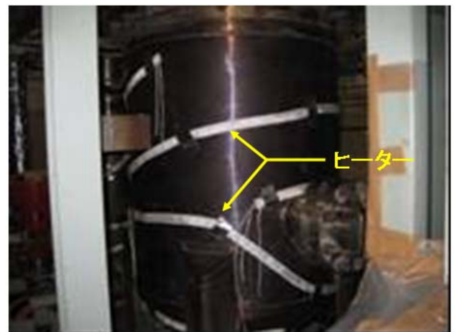
機器へのヒーター取付け状況
