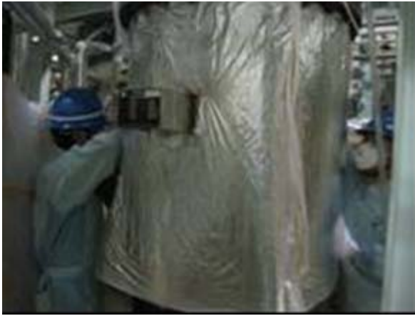
ヒーター取付け後の保温材取付け状況
