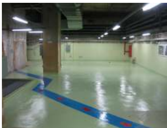
解体撤去後の第5給水加熱器付近
