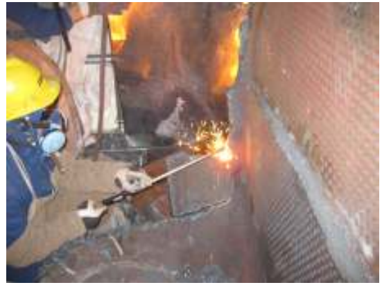
ガソリン酸素溶断器による給水加熱器水室部解体
