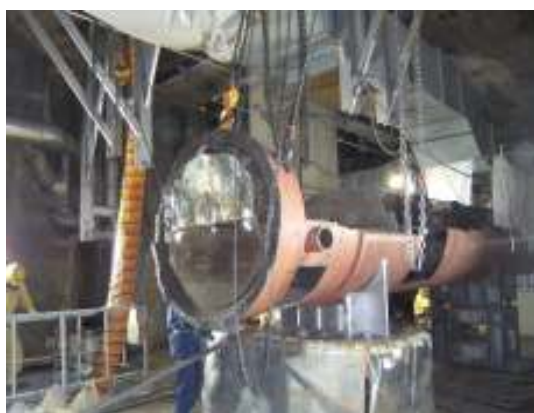
解体撤去中の第5給水加熱器
