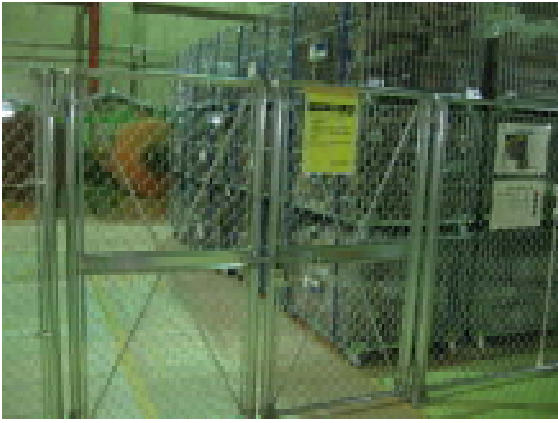
収納容器での解体撤去物の一時保管状態
