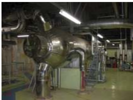
解体撤去前の第5給水加熱器付近
