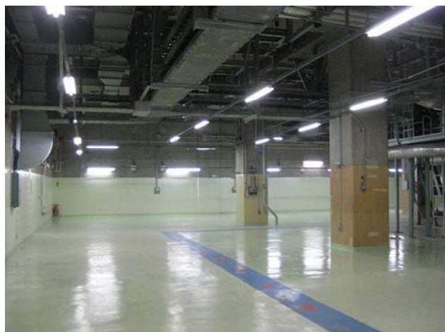
解体撤去後の第3、4 給水加熱器付近
