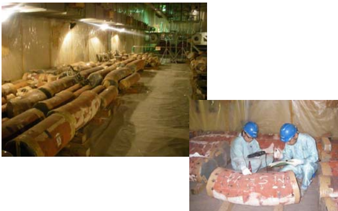
タービン系炭素鋼管の肉厚測定状況
