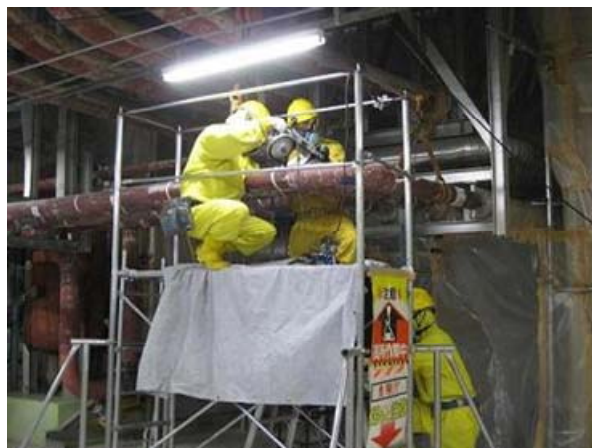
機器・配管切断開始（6/16）プレス公開
