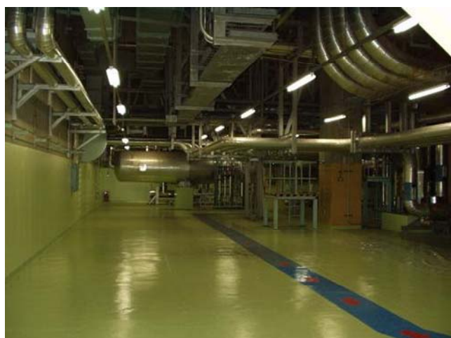
解体撤去前の第3、4 給水加熱器付近
