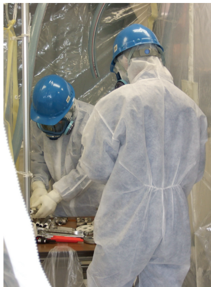
写真6 クリーンハウス内作業実技演習風景
