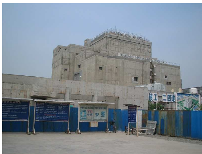
写真4 建設中の高速実験炉（CEFR）
