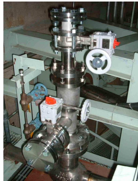
写真 4：隔離用治具
