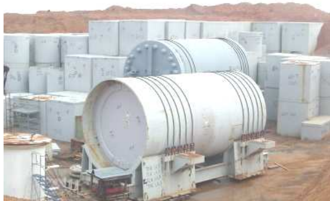
写真3：バーンウェル処分場トレンチ内に運ばれる円筒容器
