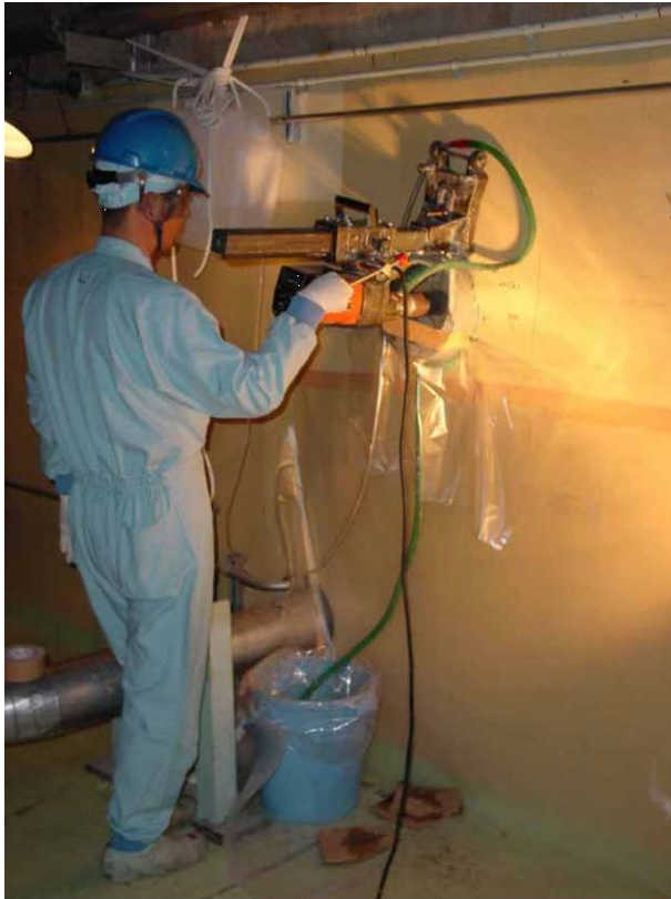
ボーリング作業風景(壁面)
