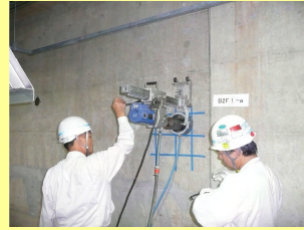
コアボーリングの状況
