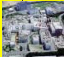
再処理施設・MOX燃料加工施設
