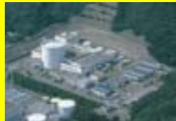
原子力発電所
