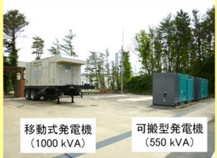
移動式発電機 (1000 kVA)      可搬型発電機 (550 kVA)
