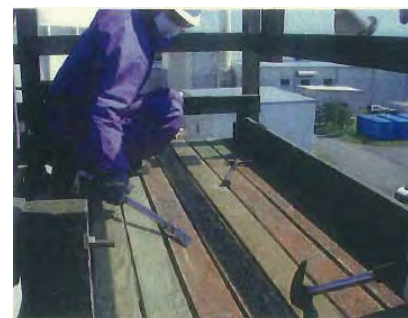
階段踊り場補修
