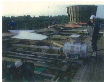
デッキ取外し
