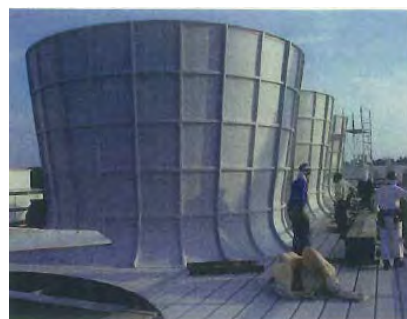
ファンスタックFRP交換
