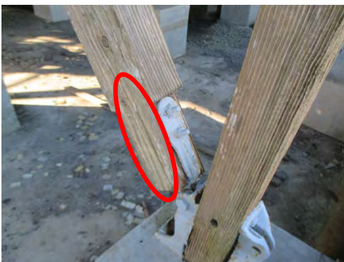
図⑦-1 倒壊後の筋かい下端部の状況 (腐朽が進んでいる 10-AB, 13-AB, 15-AB を抜粋)
