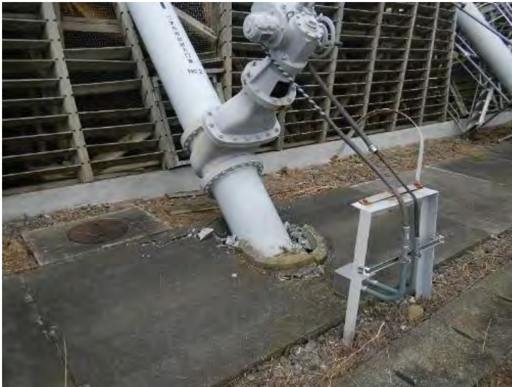
写真③ 二次冷却系配管 (No.2 セル側) 養生前 (令和元年9月11日撮影)
