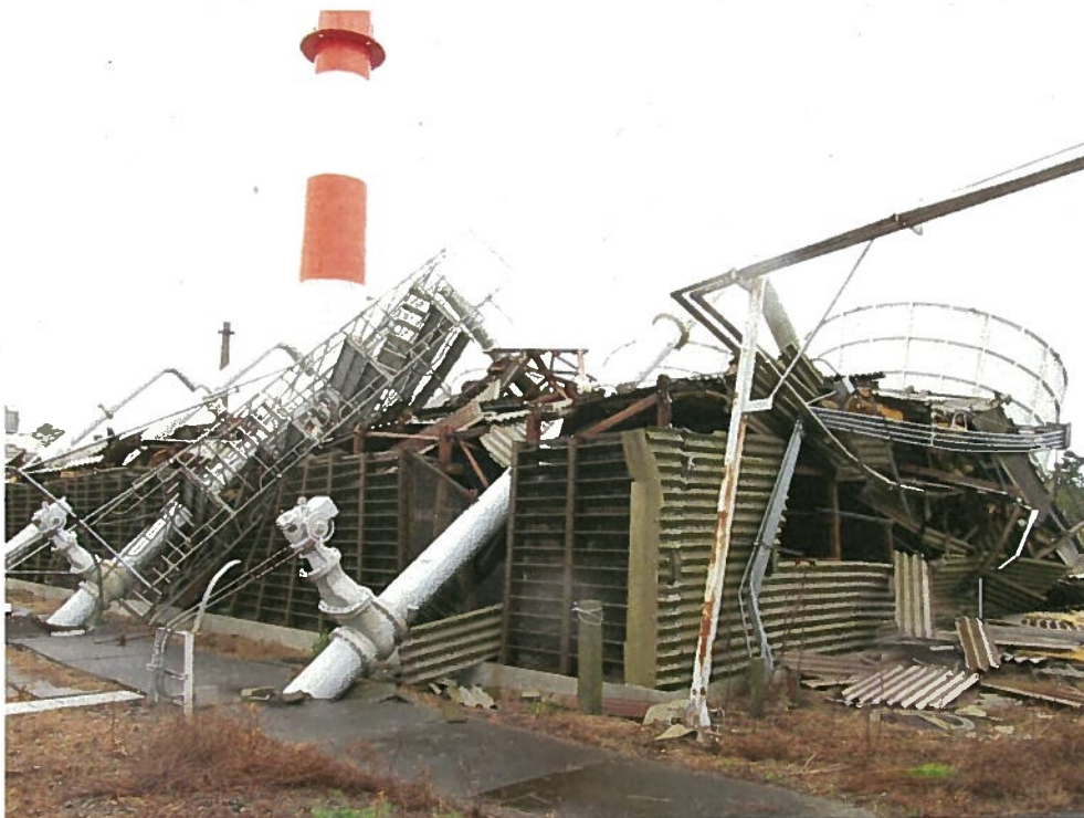
写真② 倒壊後（令和元年9月9日撮影）
