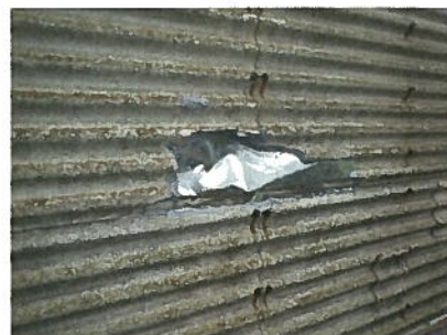
写真④ 補修後(2)（令和元年9月9日撮影）
