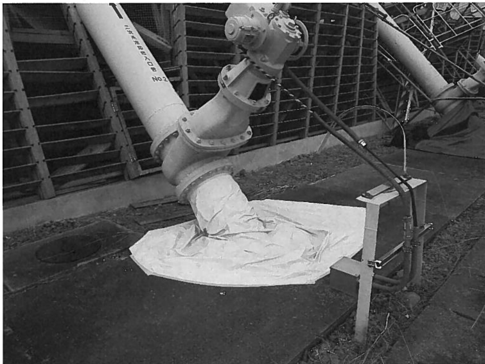
写真④ 二次冷却系配管 (No.2 セル側) 養生後 (令和元年9月11日撮影)
