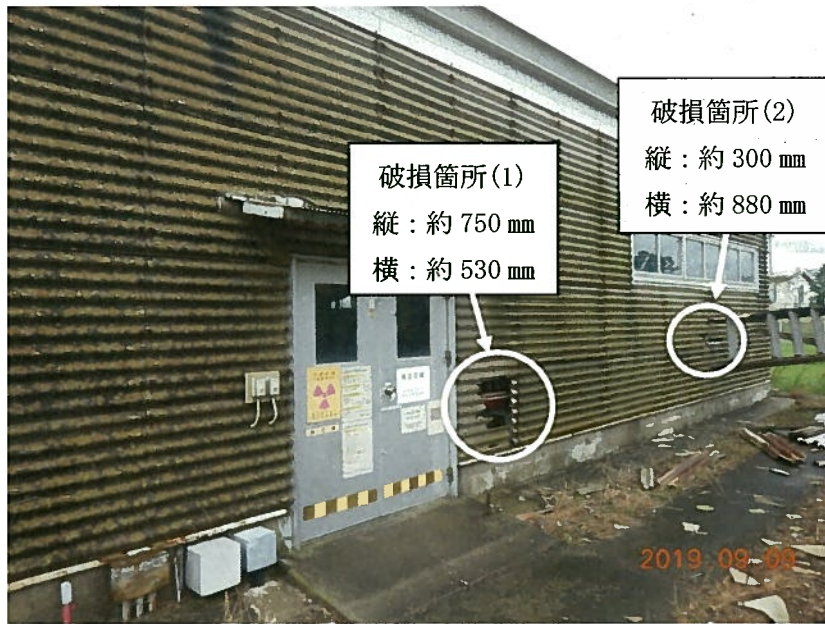
写真① 補修前（令和元年9月9日撮影）
