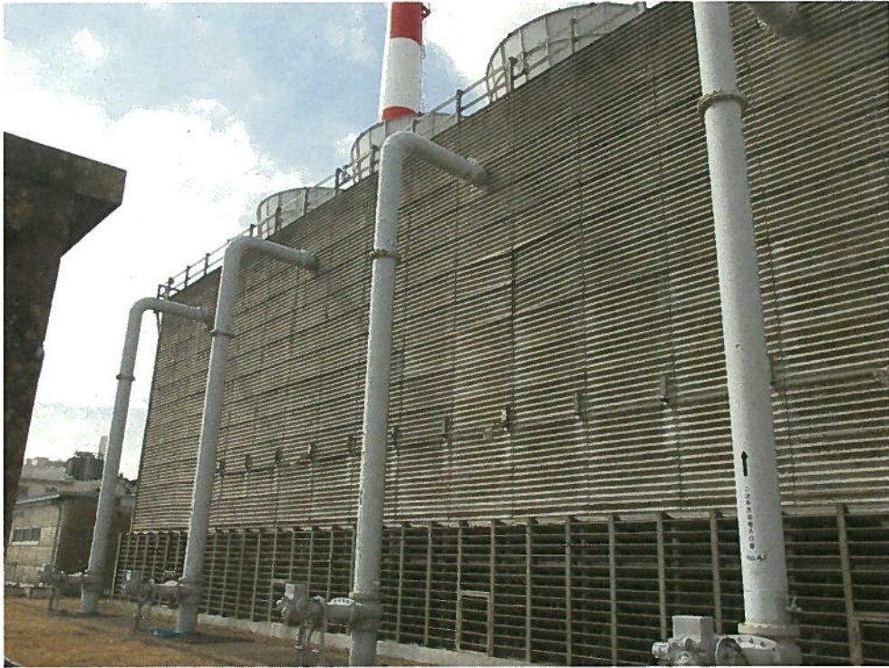
写真① 倒壊前（平成30年2月16日撮影）
