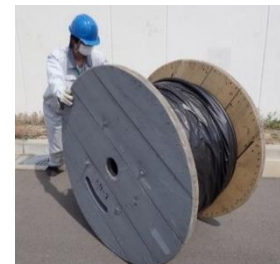
崩壊熱除去機能、水素掃気機能の維持(予備ケーブル)
