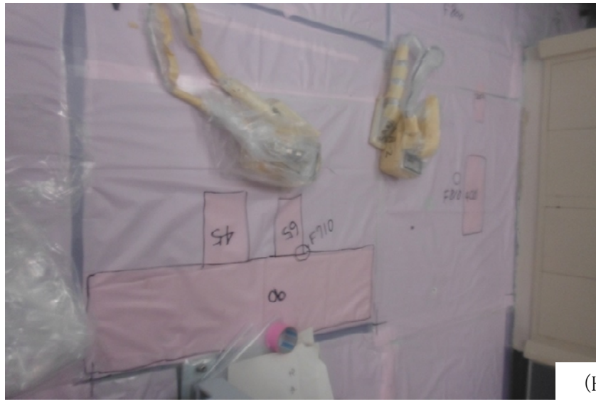
(b) 除染作業後のビニルシートによる養生の状況
