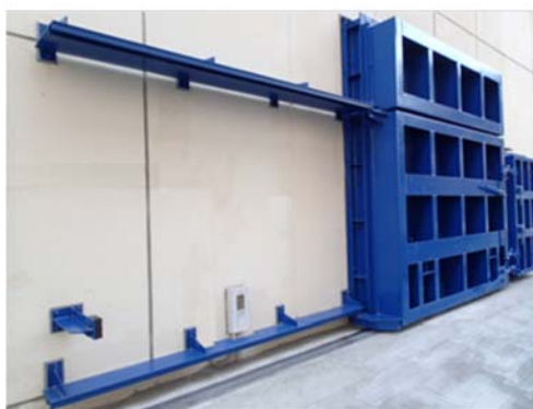
HAW施設の浸水防止対策の例(スライド式扉)
