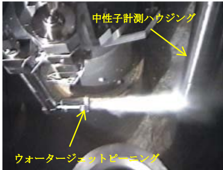
図7 炉内工事例
