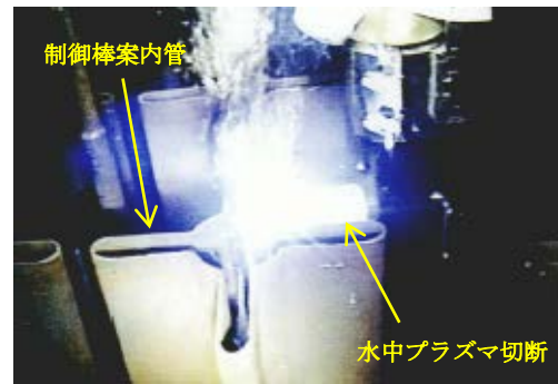
図8 動力試験炉の解体実地試験例
