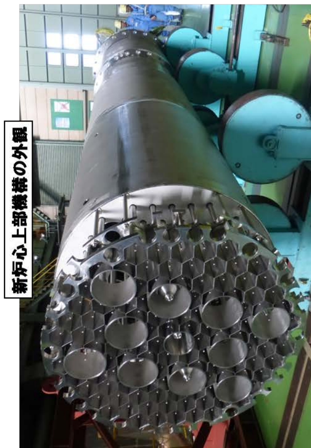
図2 炉心上部機構交換作業の概況
