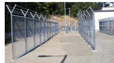
防護フェンス
