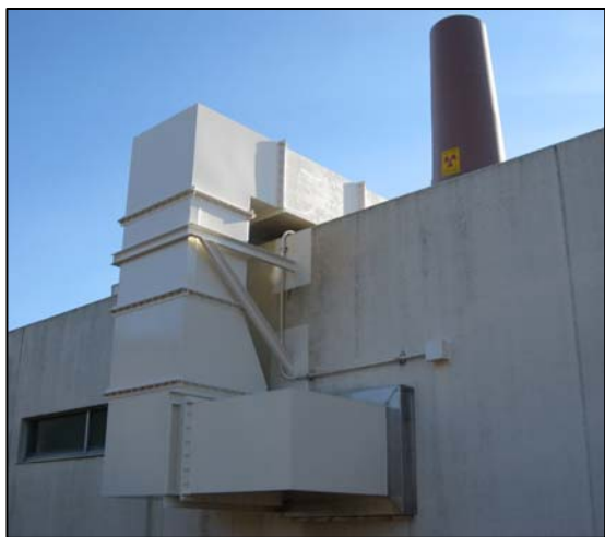
排気ダクト外観
