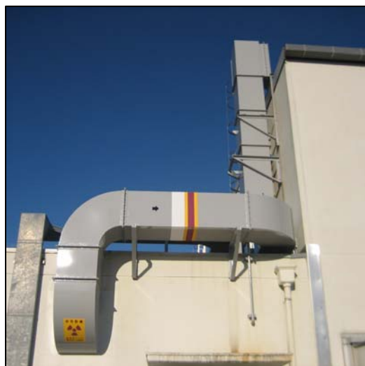
排気ダクト外観
