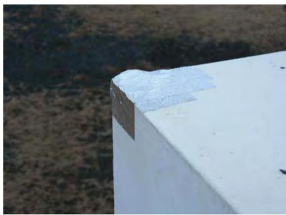
腐食孔をアルミ材の補修テープにより応急措置
