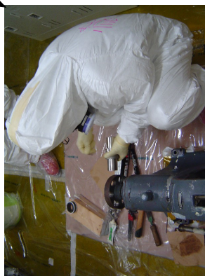
⑤ セットスクリュー締付け確認 (2人目)
