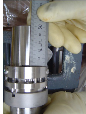
③ メカニカルシール組込み寸法確認
