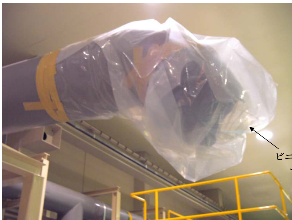
ダクト上部破損箇所
