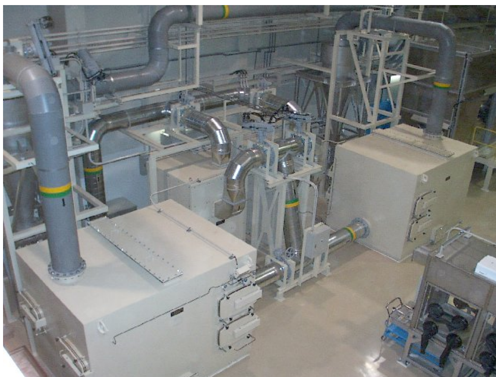
局所排気処理装置 破損前の状況(建設当時)
