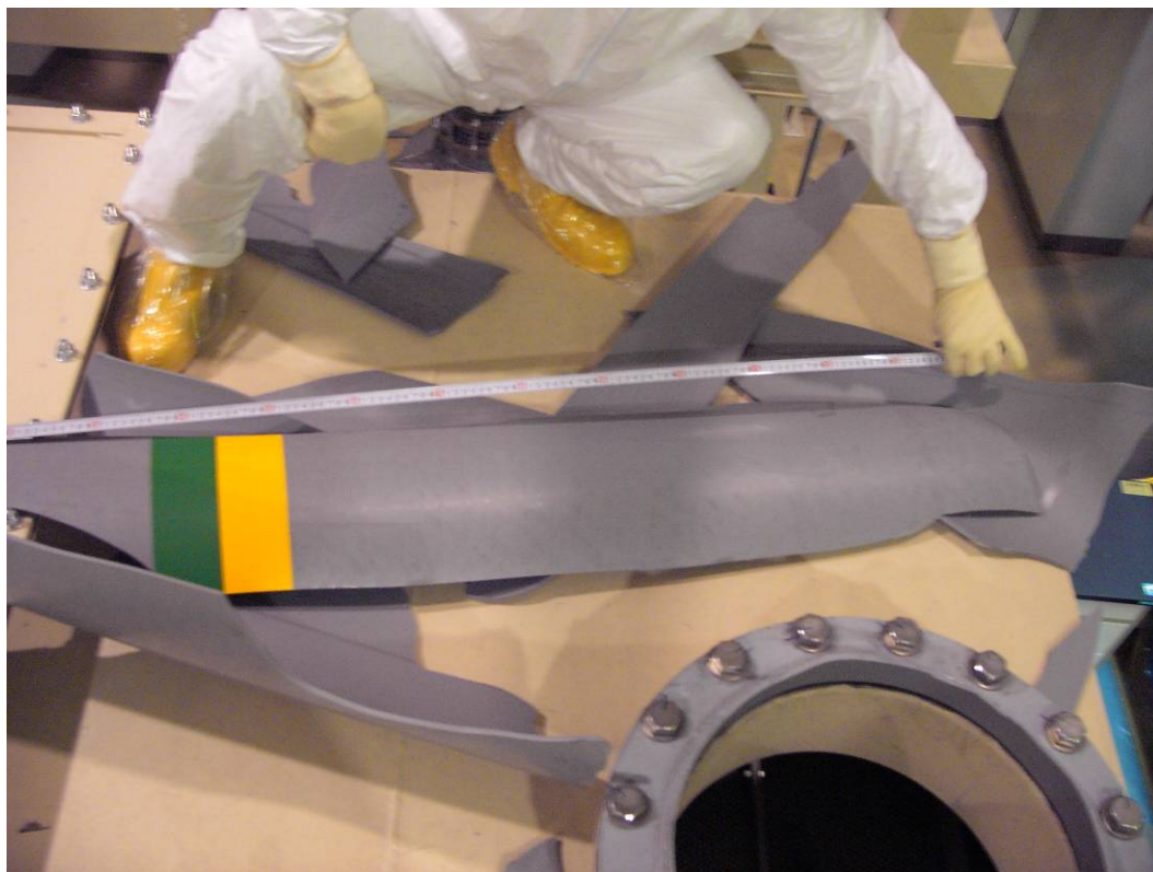
写真-1(1) 遠心機処理設備用局所排気処理装置の排気ダクト破損状況
