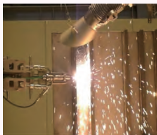
遠隔解体（レーザー切断）
