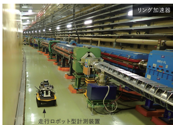
走行ロボットを用いた測定試験
