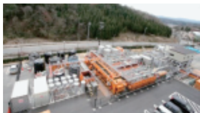
排水処理設備
