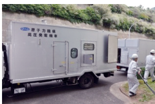
電源車接続訓練
