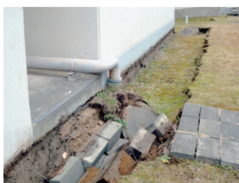
NUCEF(燃料サイクル安全工学研究施設)建家周辺の地盤沈下場所の補修を実施
