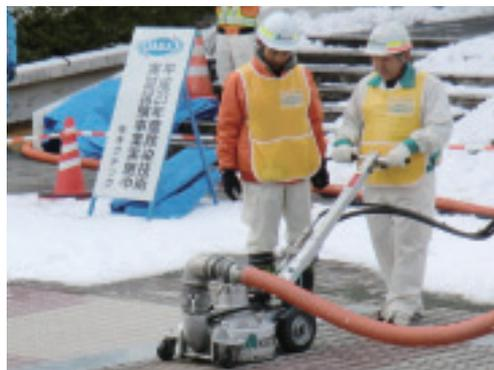
超高圧水表面処理工法による除染
