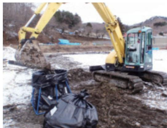
除染モデル実証事業での農地の表土除去作業 (大型重機使用)
