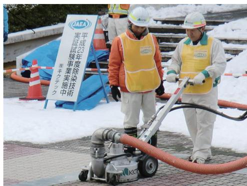
超高压水表面処理工法による除染
