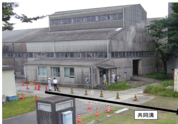
汚染の確認された箇所（共同溝）
