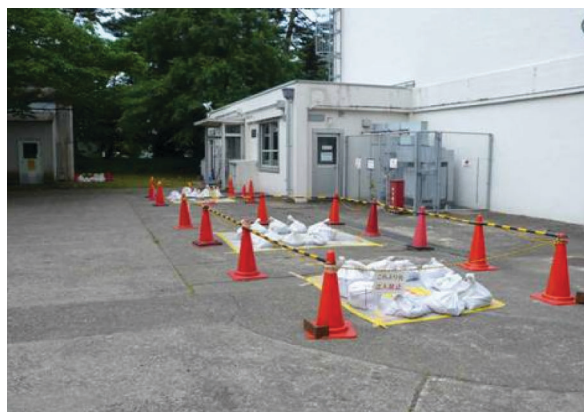
汚染の確認された箇所（排水枡）
