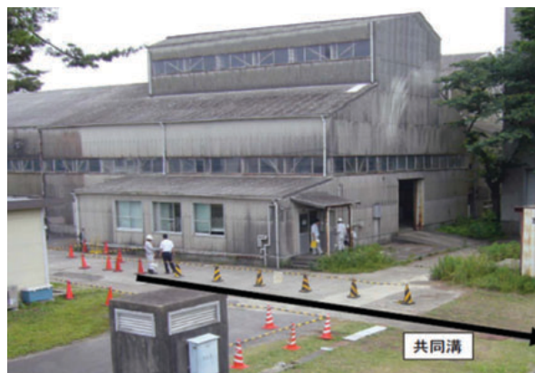
汚染の確認された箇所（共同溝）
