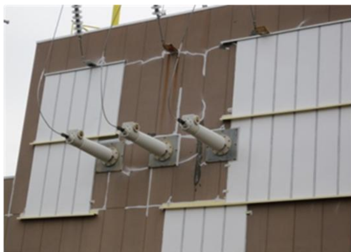
南受電所の応急措置
