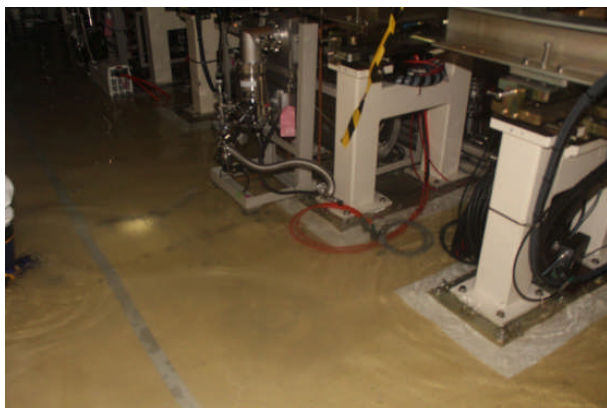
トンネル内 地下水漏洩
