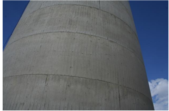
排水処理施設排水塔の円周方向の亀裂
