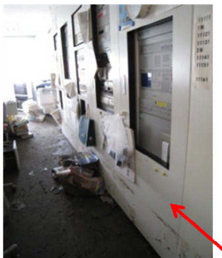
館内制御機器の浸水跡
