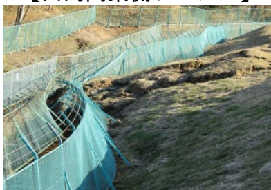
地滑りにより損傷
