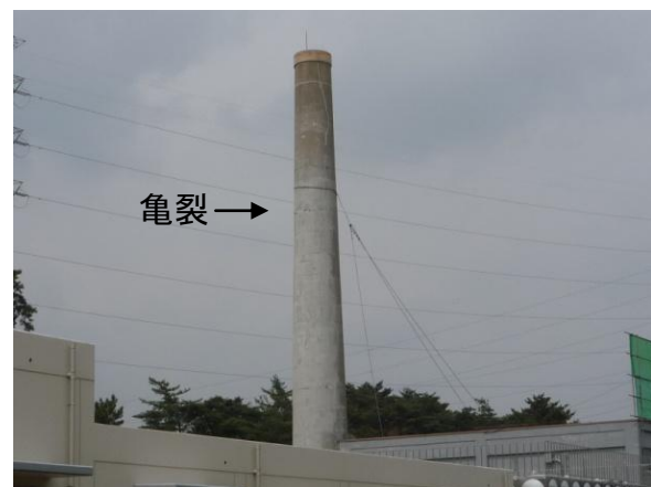
第1ボイラー(停止中)煙突の亀裂及び支線 (支線張りを行い、国道 245 号線側への倒壊を防止) 煙突部分については 4 月 19 日撤去終了
