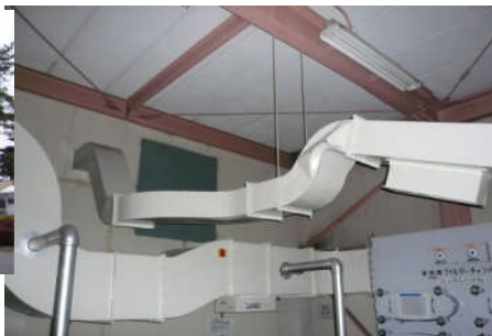
排気機械室給気ダクトの損傷。 施設の換気には影響なし
