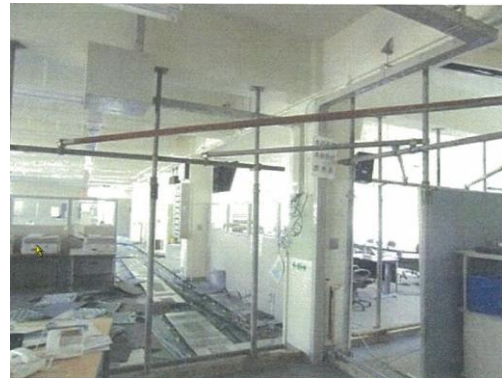
室内の倒壊防止
