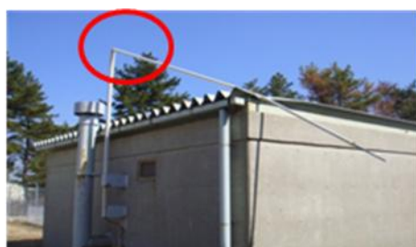
危険物倉庫避雷針破損
