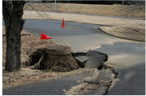
排水処理施設排水塔の円周方向の亀裂
