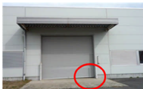
放射性廃棄物保管施設 附属建家入口シャッター破損
