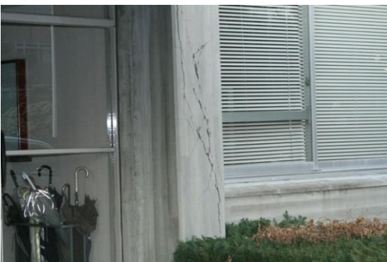
南側 柱ひび割れ
