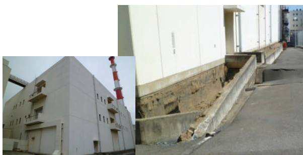
南側側面部の地盤が0.5m程度陥没
