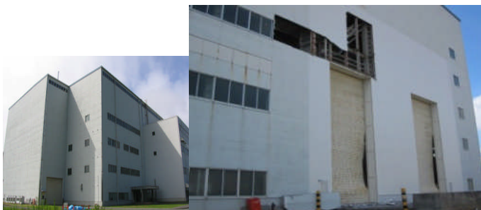
建屋の北側、南側の外壁が破損
