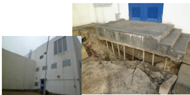
出入口部の地盤が0.5m程度陥没
