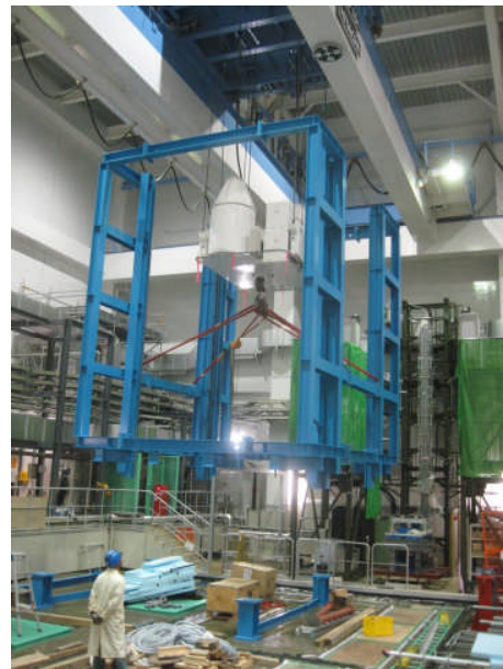
↑ クレーン稼働、傾いた 機器などの修復
