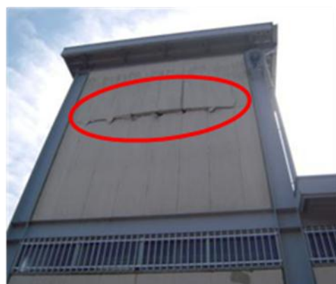
附属管理施設外壁破損
