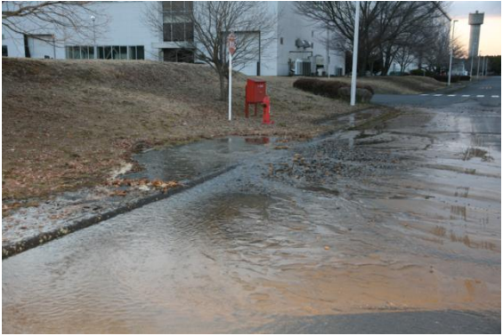
構内配水管(工業用水)の損傷
