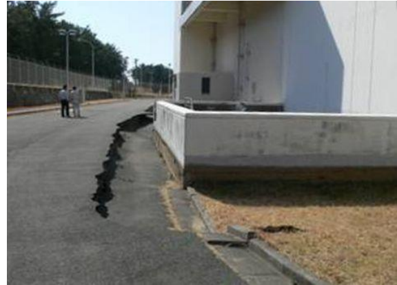
NUCEF実験棟周辺の陥没
