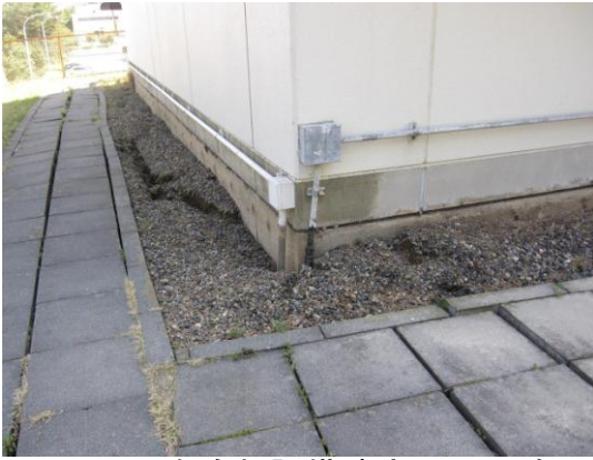
JRR-3 二次冷却設備建家周辺の陥没
