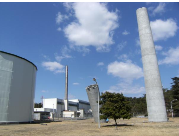
JRR-2 排気筒及び倒壊部分 (廃止措置中のため核燃料物質はない)
