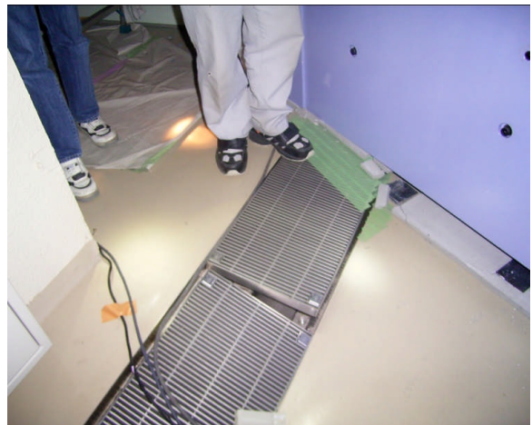
西側増設建物部の段差
