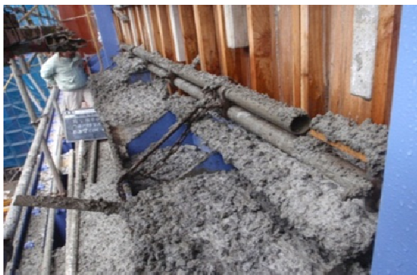
コンクリート壁の損傷
