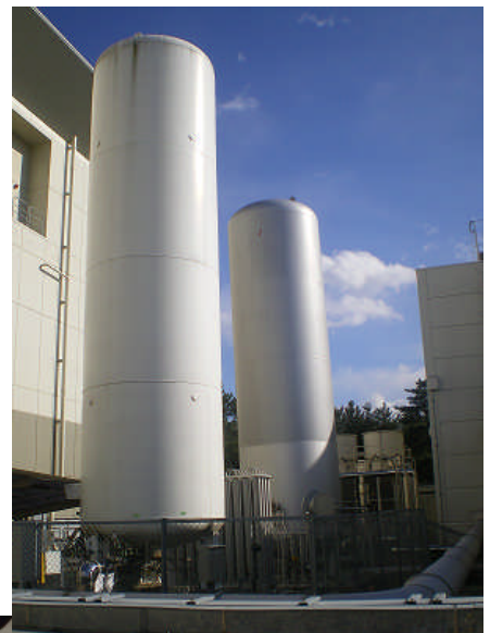
液体窒素タンクの傾き
