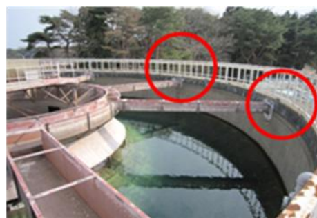
浄水場の固定治具一部損傷
