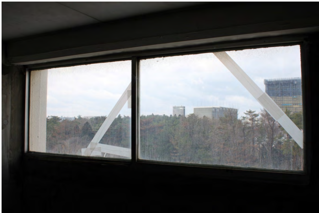
応急処置後（テープ補修）
