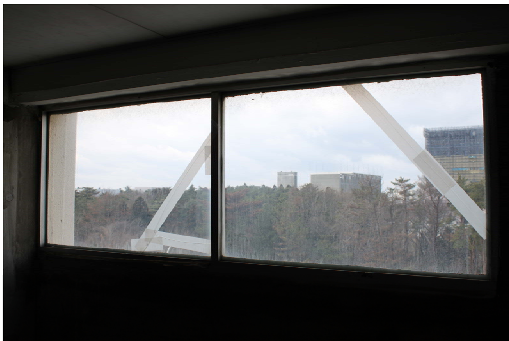
応急処置後（テープ補修）
