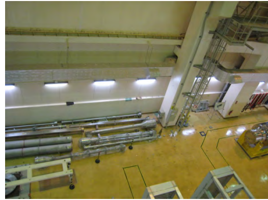
3階管理区域サービスエリア増設北側内壁
