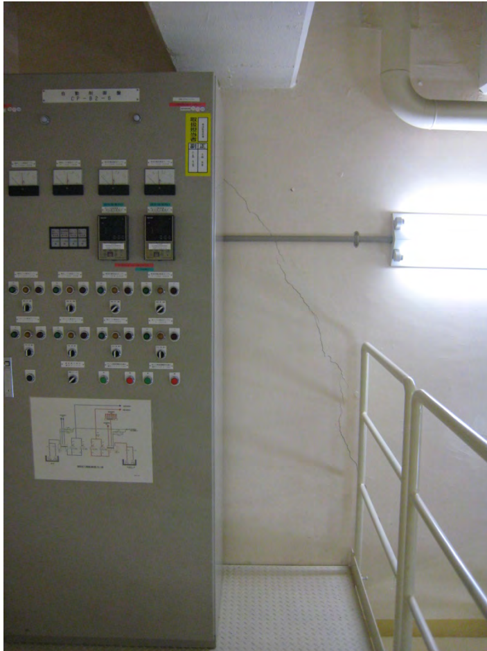
写真 13 第 2 廃液タンク室南側壁面(1)
