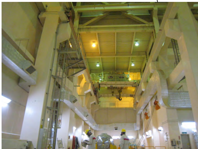
3階管理区域サービスエリア増設東側内壁
