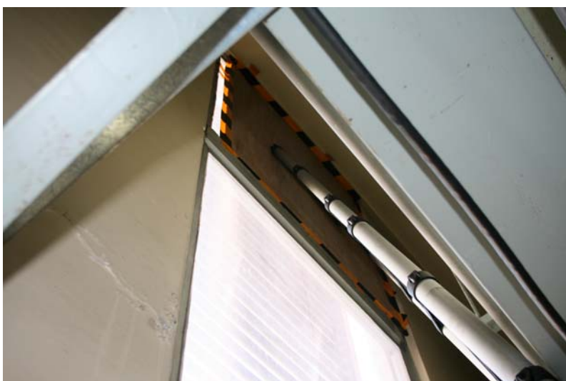
AGF 排風機室外壁ガラス窓の補修状況
