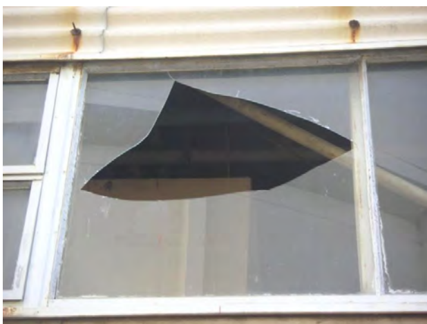
機械室窓破損状況（3箇所）
