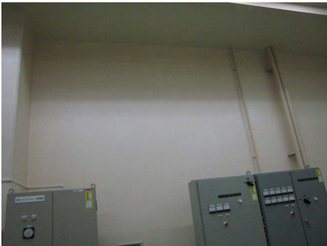
写真 6 操作室西側壁面
