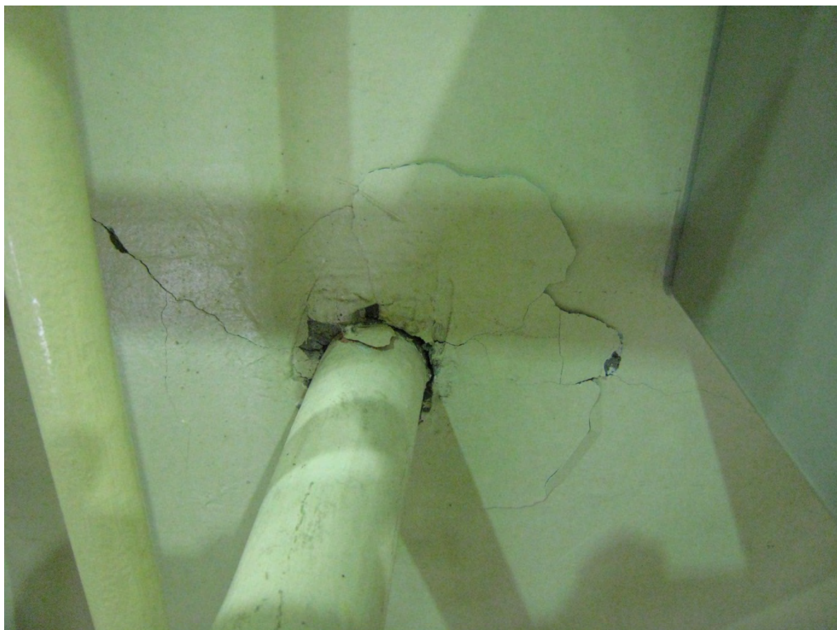
写真1 サービスエリア既設4階手すり付け根
