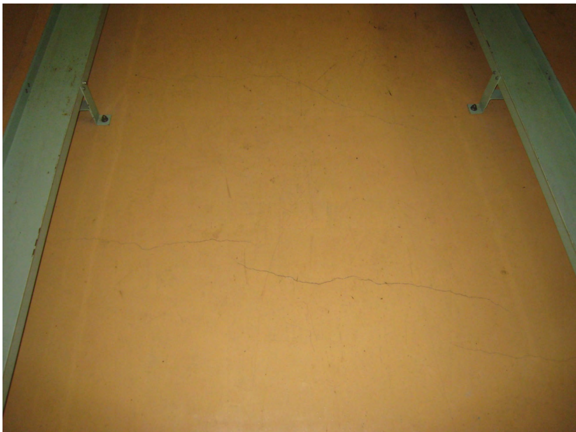
写真 11 第2 キャスクコリダの亀裂(2)
