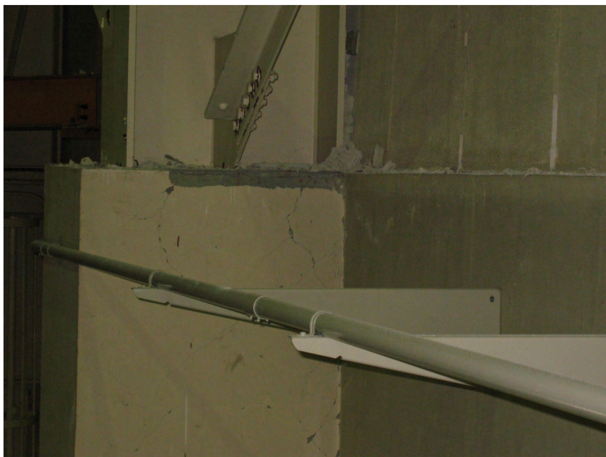
写真2 サービスエリア既設4階内壁支柱
