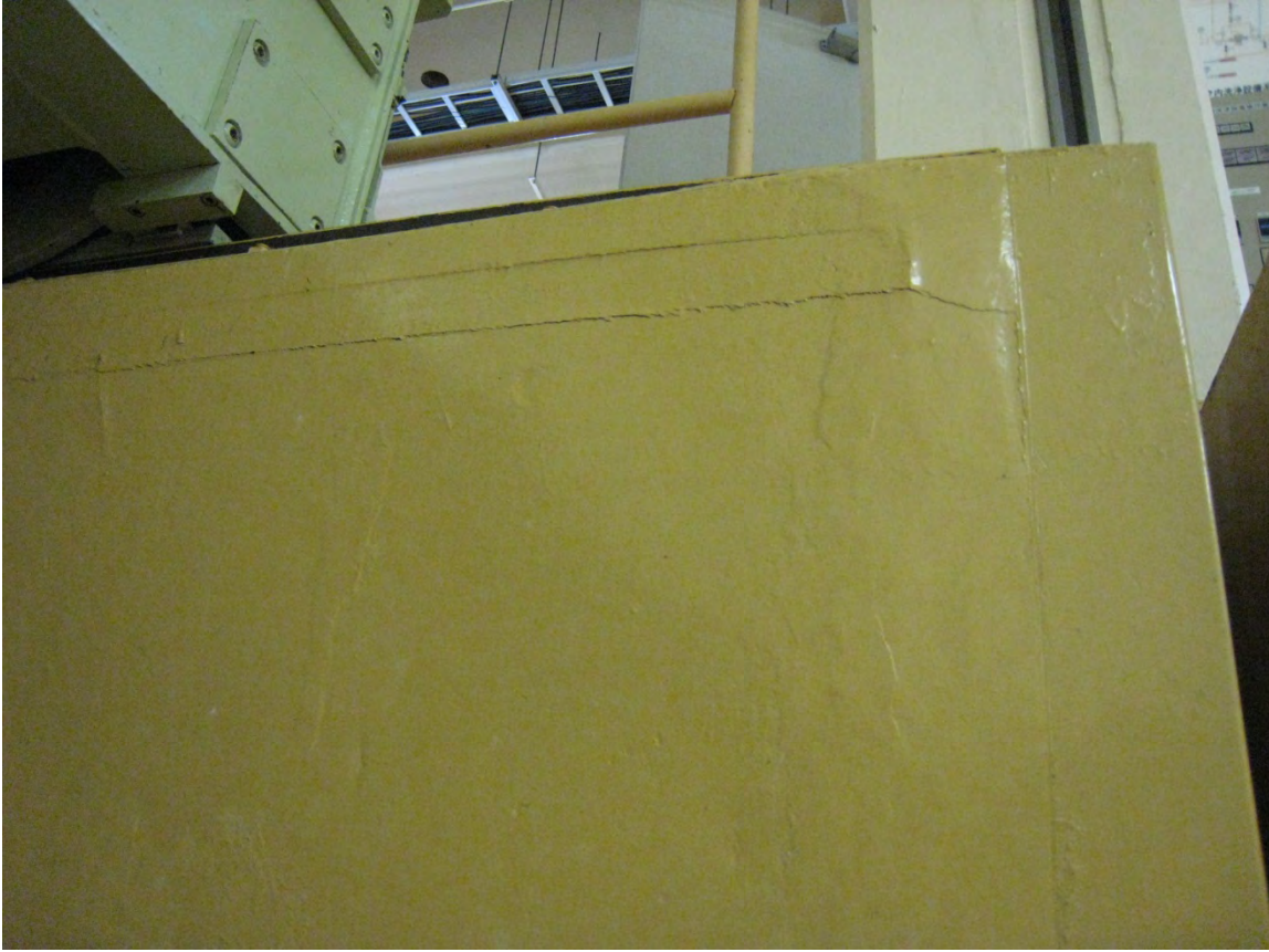
写真 12 第 2 キャスクコリダの亀裂(3)
