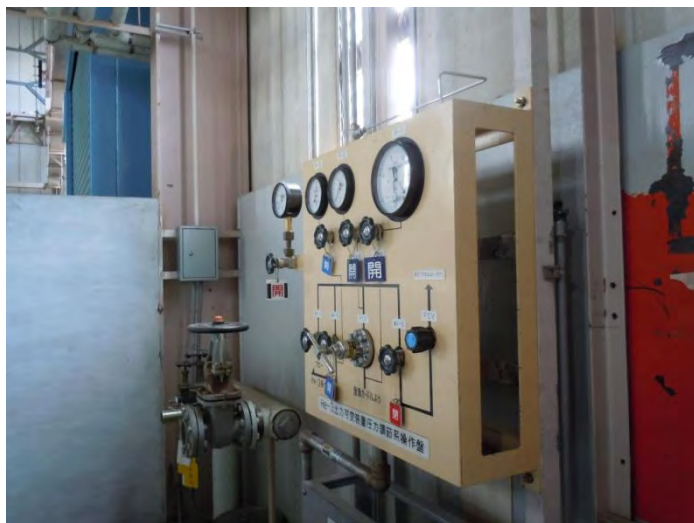
N 2 供給系配管からのガス漏れ
