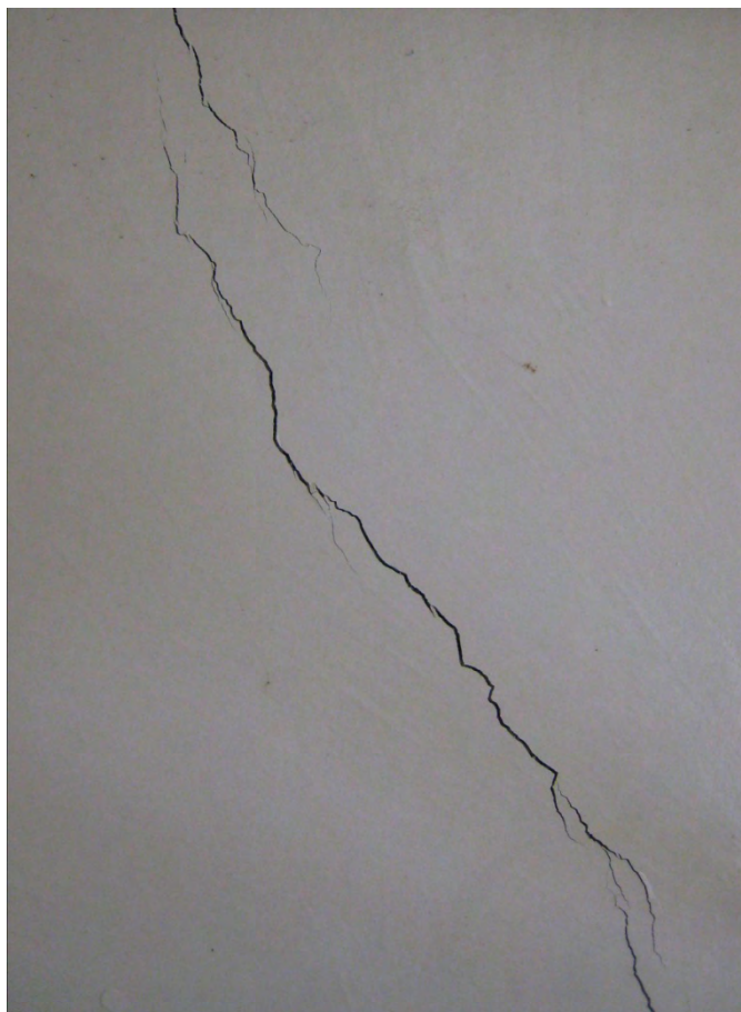
写真 14 第 2 廃液タンク室南側壁面(2) 拡大
