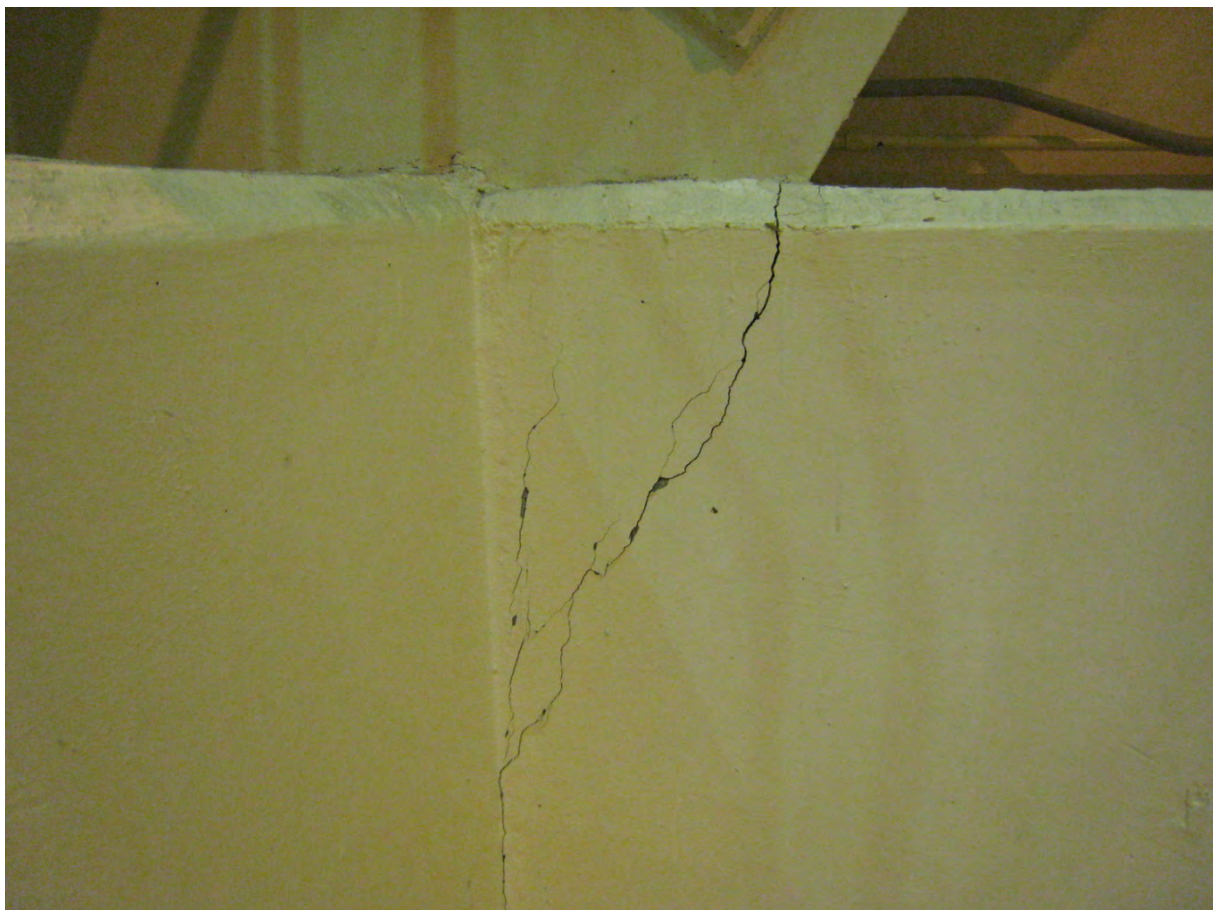
写真 5 サービスエリア増設 4 階内壁支柱
