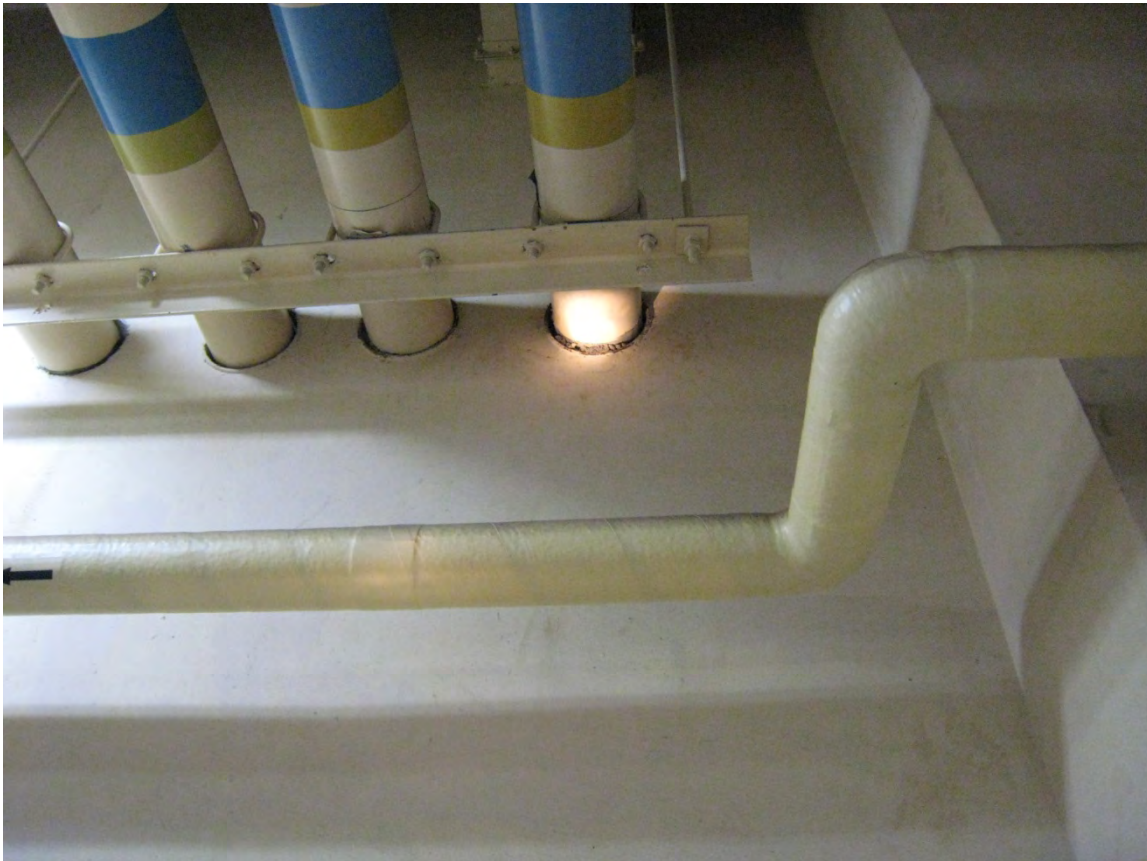
写真 18 排風機室壁面と配管の接合部
