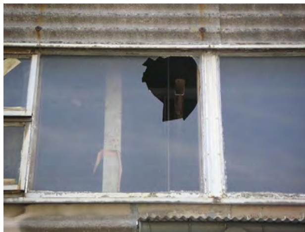
機械室窓破損状況（3箇所）
