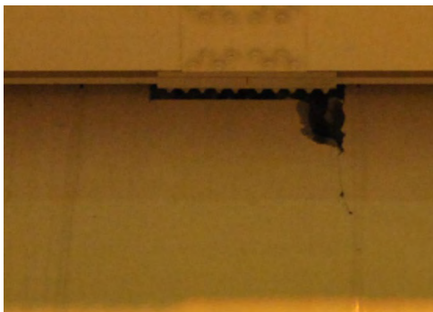
3階管理区域サービスエリア増設北側内壁
