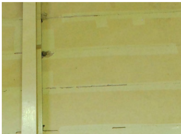
3階サービスエリア既設南側内壁
