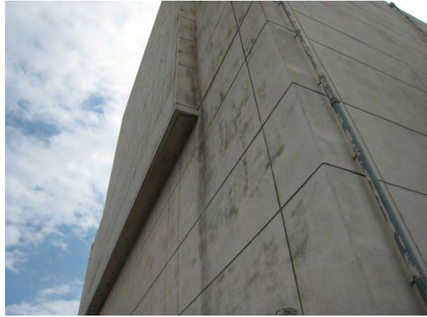
3階管理区域サービスエリア増設北側外壁
