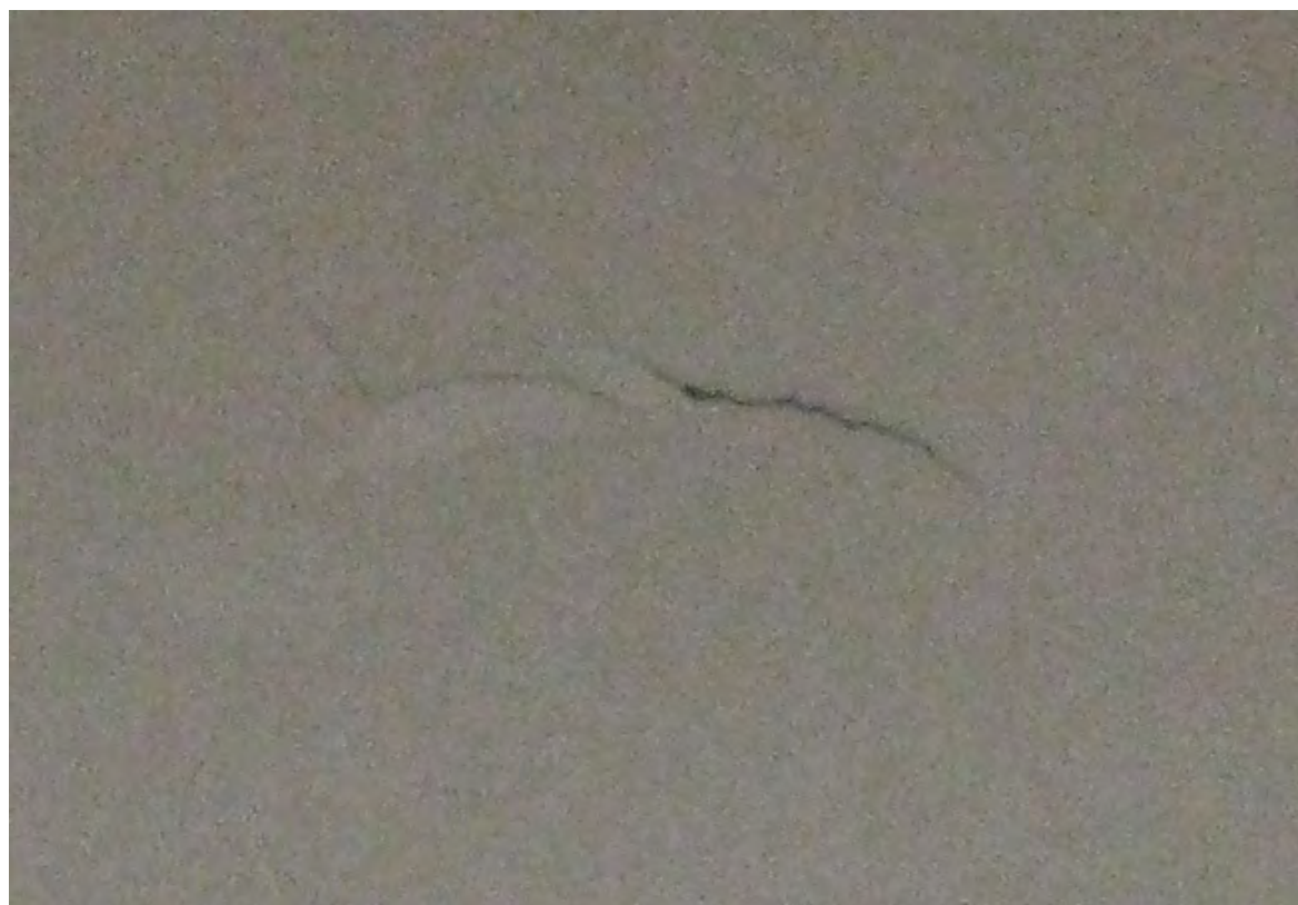
写真 7 操作室西側壁面 (拡大)
