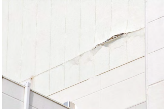
3階管理区域サービスエリア既設西側外壁
