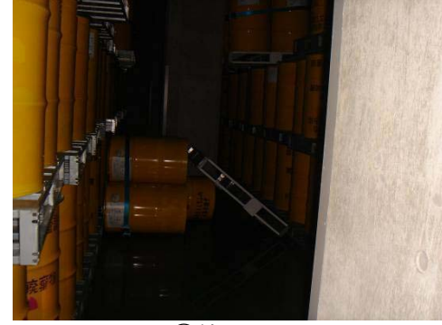
②第2UWSF-2 (管理区域) ドラム缶落下・蓋外れなし(保管室4F)
