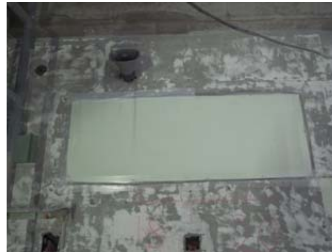
写真 塩ビ板取付け(応急処置後)
