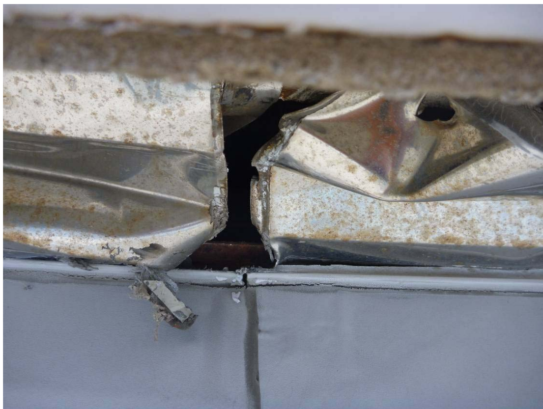
写真 13 屋上（吹抜側から事務室側方向）（被害箇所⑬）
