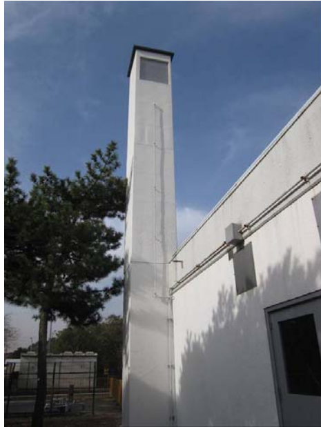
排気筒全景（北側）
