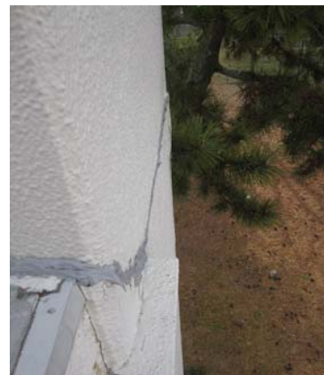
亀裂箇所（コーキング後）
