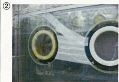
補修後 (テープ固定)
