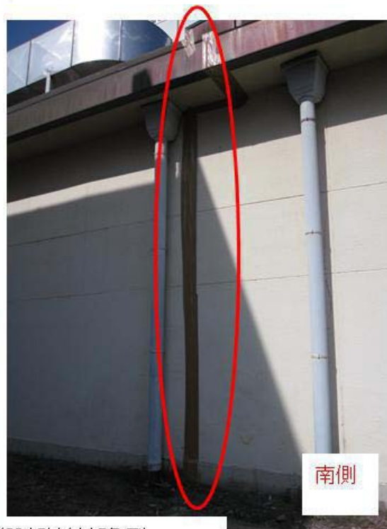
⑤ A棟管理区域増設部接続部亀裂 (メバリ養生済み)
