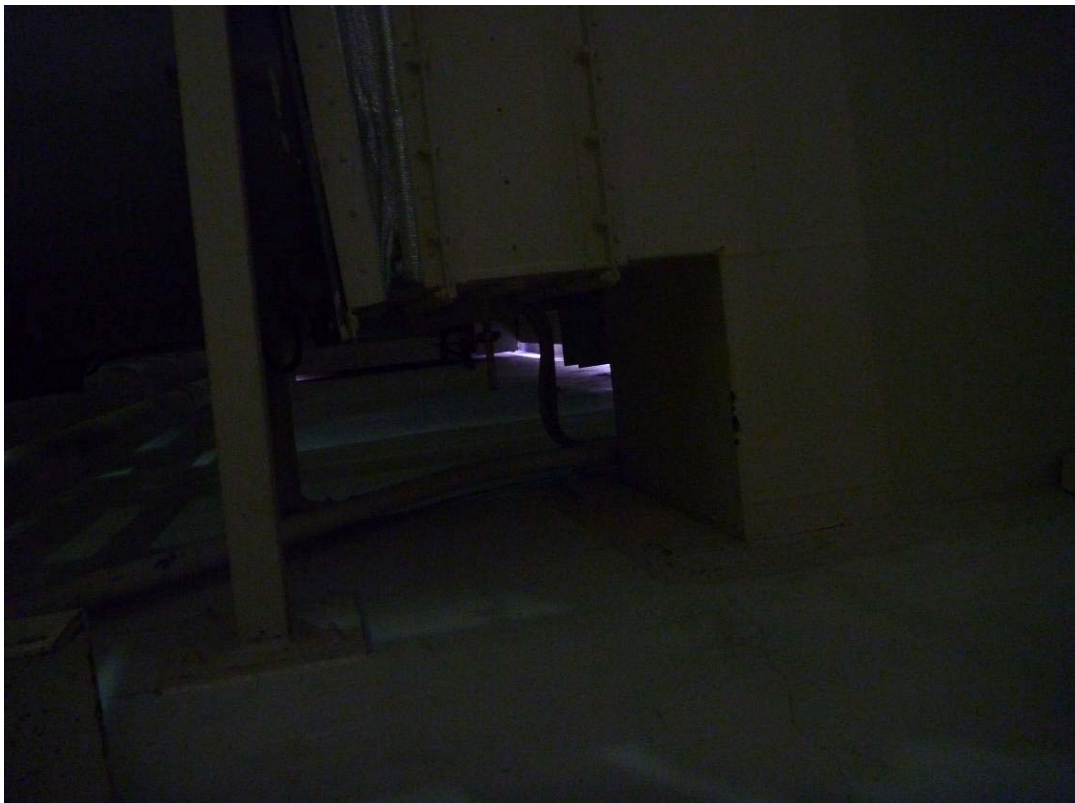
写真4 工学試験室3階より天井方向 (被害箇所④)
