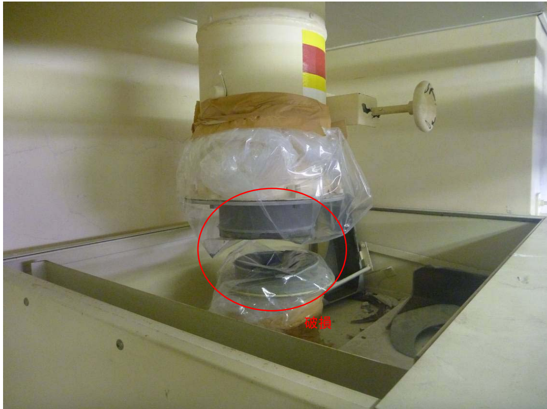
①試験室4フード14上部
