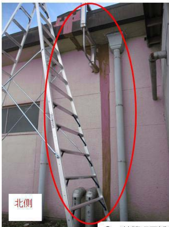
⑤ A棟管理区域増設部接続部亀裂 (メバリ養生済み)
