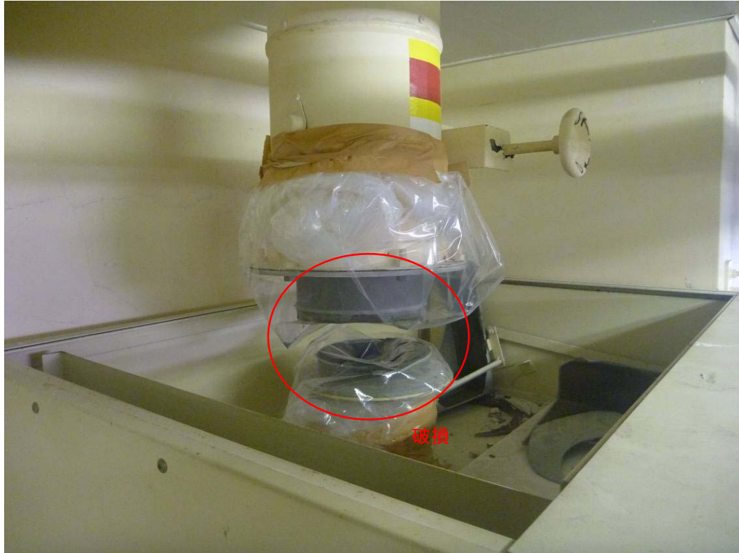
①試験室4フード14上部
