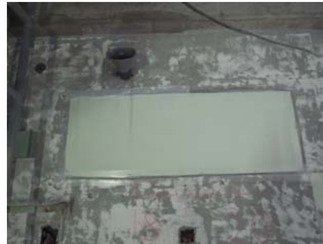
写真 塩ビ板取付け(応急処置後)
