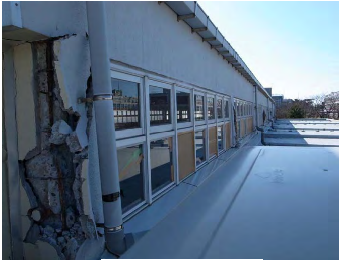
工場北側高部の柱
