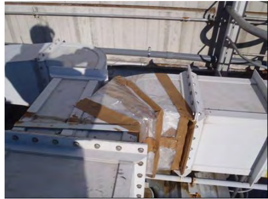
屋外ダクトの養生
