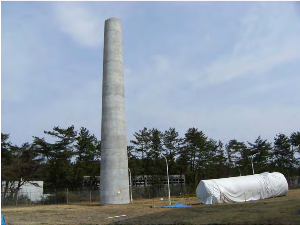
排気筒の応急処置状況
