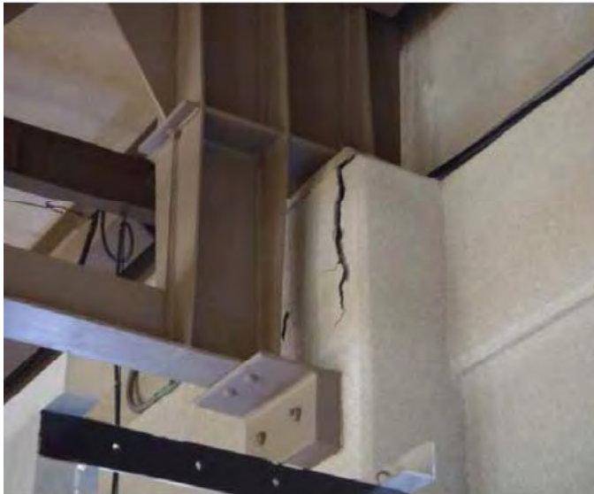
炉-36 第2廃棄物処理棟 屋根支柱上部の損壊
