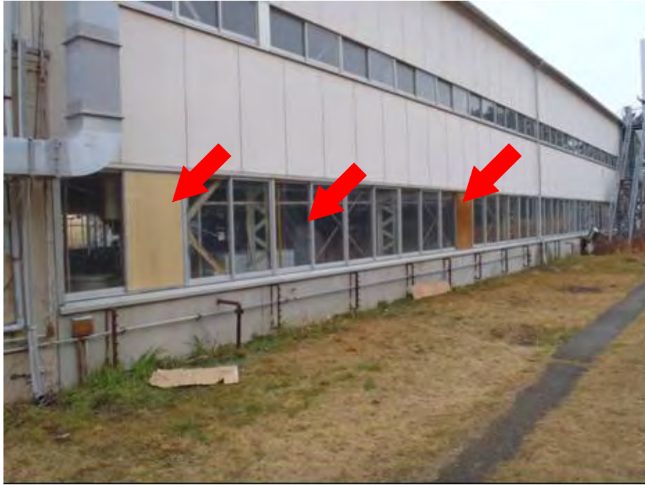
窓ガラスの養生
