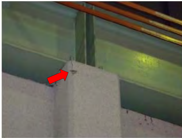
炉-37 第2廃棄物処理棟 クレーンレールベース部及び支柱上部の損傷
