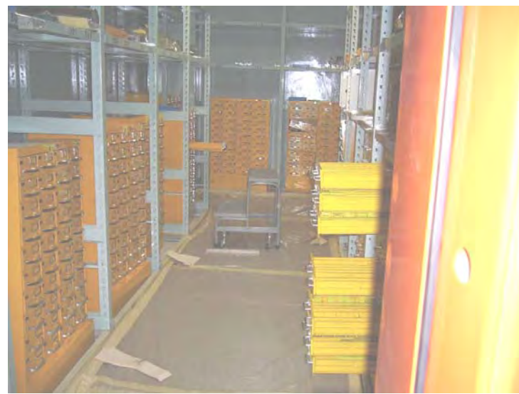
炉-21 FCA 一部燃料の落下・破損及び燃料収納キャビネットの破損
