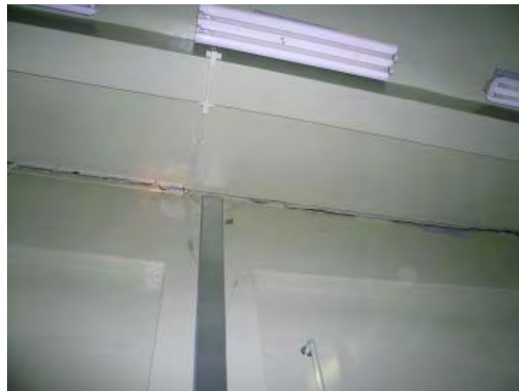
燃料貯蔵室内壁西側と天井とのつなぎ目
