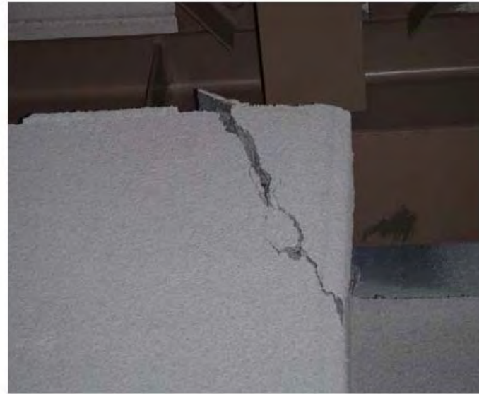
炉-36 第2廃棄物処理棟 屋根支柱上部の損壊
