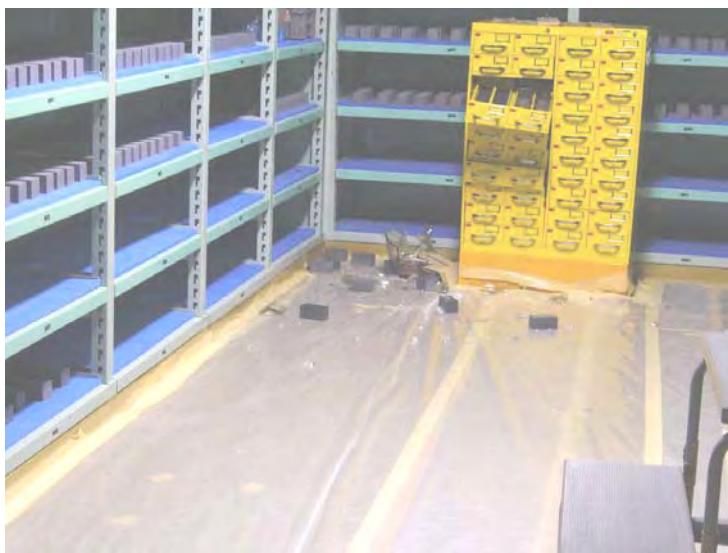
炉-21 FCA 一部燃料の落下・破損及び燃料収納キャビネットの破損
