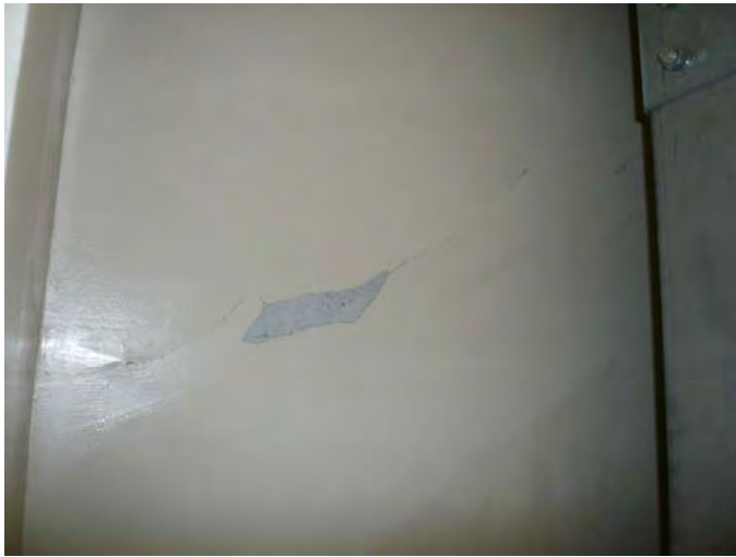
炉-28 NUCEF 制御室壁及び階段室の塗装はがれ
