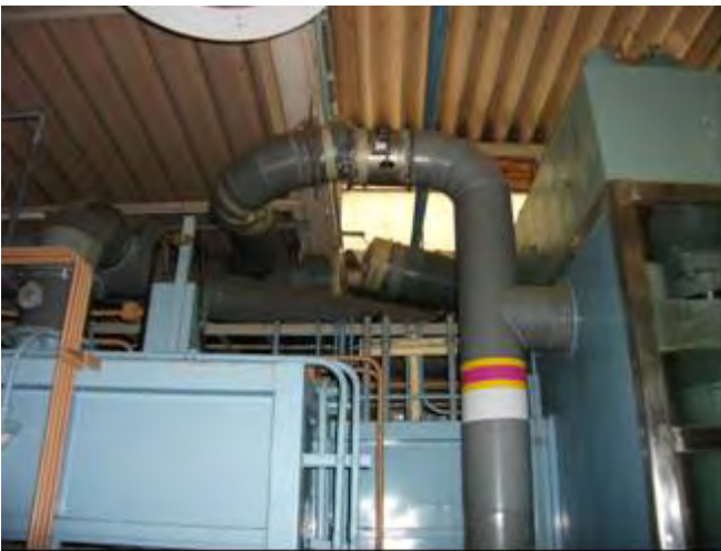
排気ダクトの養生処置
