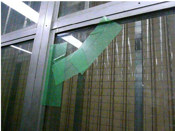
炉-20 FCA 管理区域境界のガラスにひび割れ
