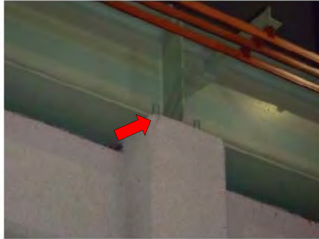
炉-37 第2廃棄物処理棟 クレーンレールベース部及び支柱上部の損傷
