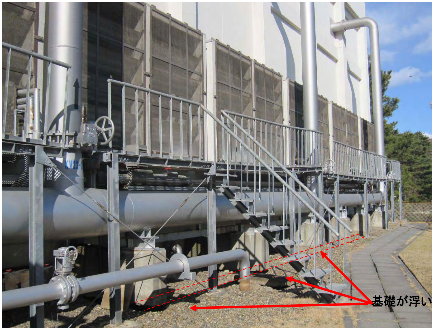
炉-04 JRR-3 地盤沈下による2次冷却材配管支持の基礎コンクリートの露出等
