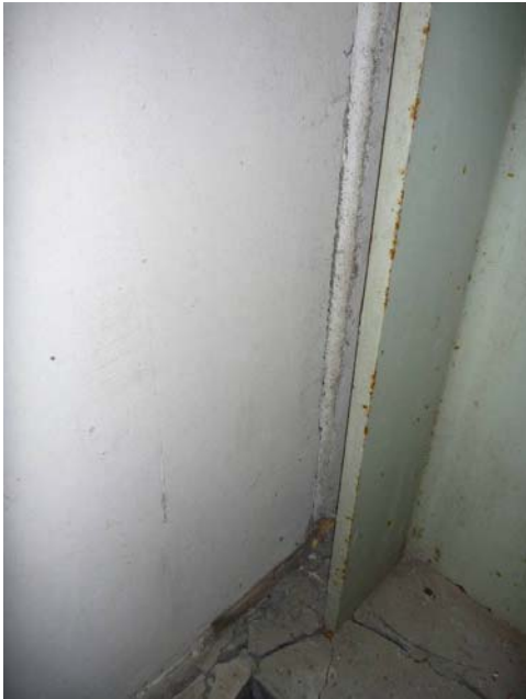
写真11 管理器材倉庫 (工学試験室南西部側壁)
