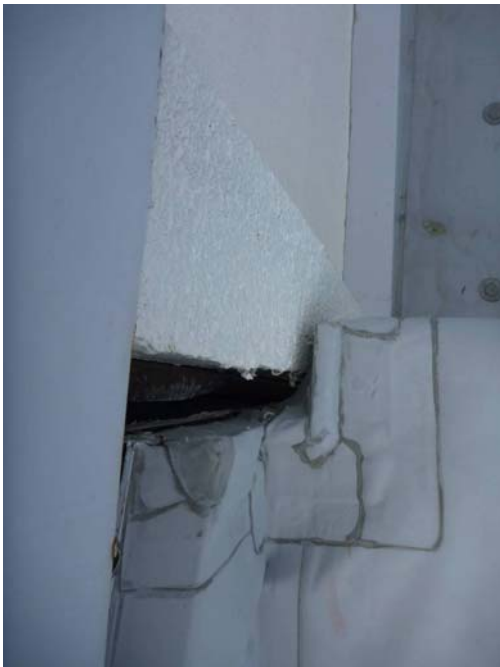
写真12 屋上 (4階方向を見下ろす)
