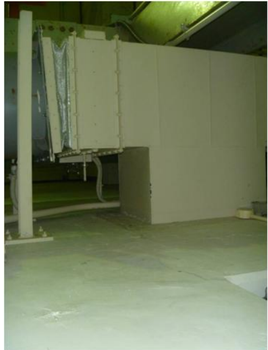
外部よりアルミテープにて補修、塩ビ シートにてシール
