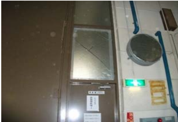
試験室(1)扉上ガラス破損 (ビニルシートによる補修状態)
