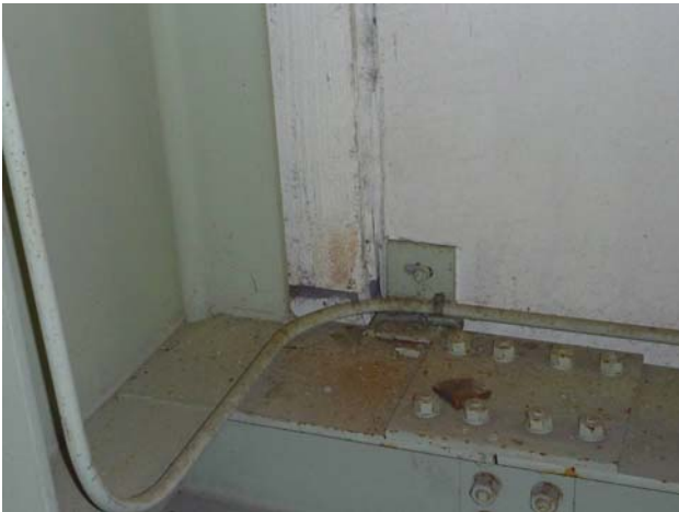
写真10 管理器材倉庫 (工学試験室北西部側壁)
