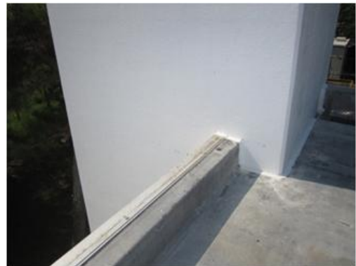
排気塔周囲を鉄筋コンクリートにて補強
