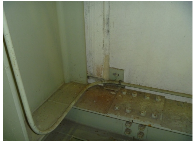
亀裂部にシリコン樹脂を充填
