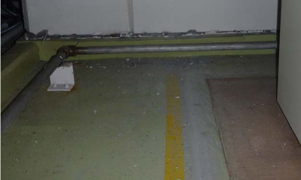
写真9 工学試験室1階 (管理器材倉庫側壁)
