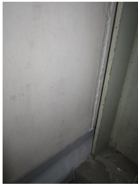
亀裂部にモルタルを充填、塩ビシートにてシール
