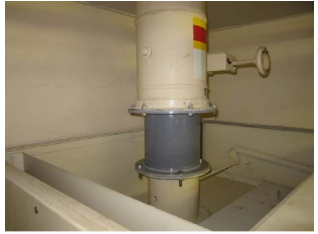
塩ビ製ダクトにより接続
