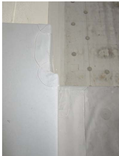
アルミテープにて補修、塩ビシートにてシール
