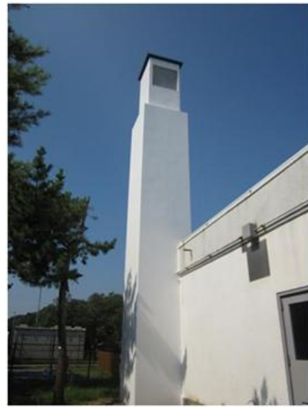
排気塔周囲を鉄筋コンクリートにて補強
