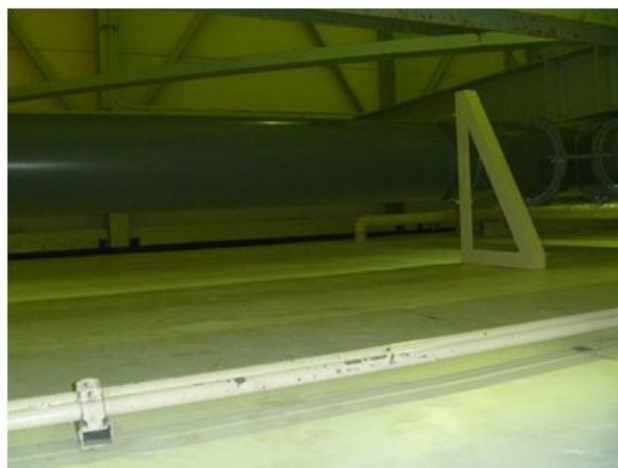
外部よりアルミテープにて補修、塩ビ シートにてシール
