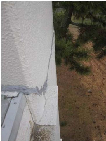
コーキング後の亀裂箇所(南側)
