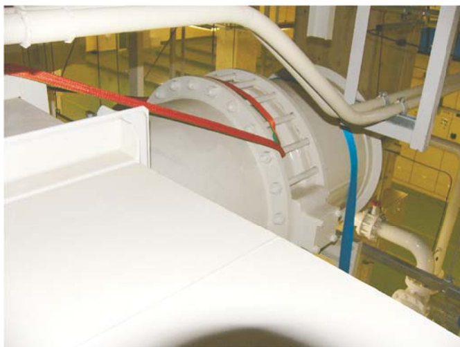
第2PWSF① 第2PWSF室内系の排気ダクト損傷
