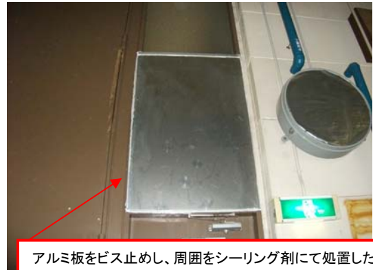
ガラス窓全体の閉止処置を実施
