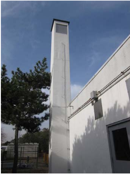
排気筒全景(北側)
