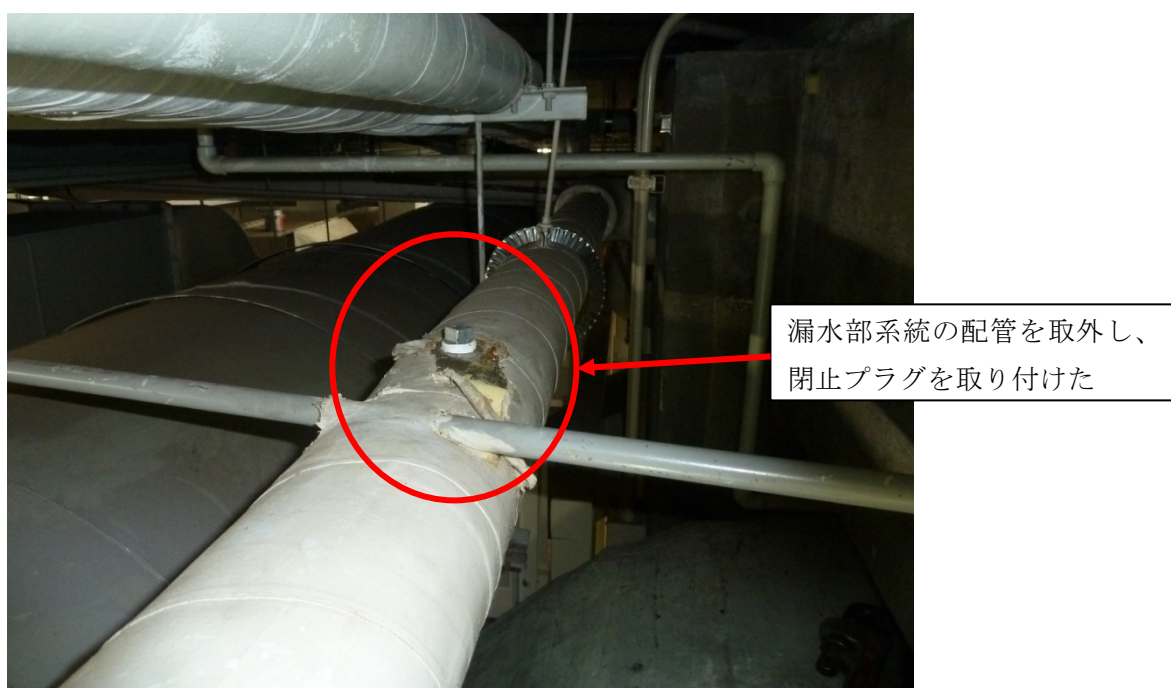
補修後（主管の分岐部に閉止プラグ取付け）
