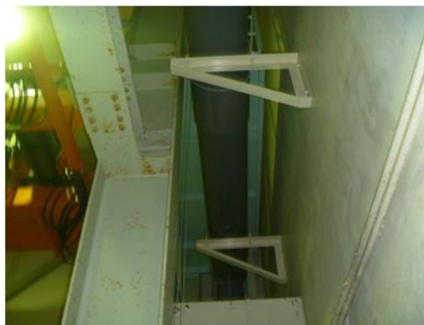
外部よりアルミテープにて補修、塩 ビシートにてシール
