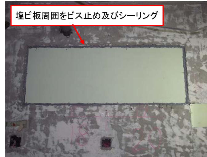
補修後 ガラス窓全体の閉止処置を実施
