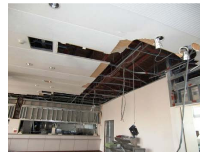
構内食堂2階の状況
