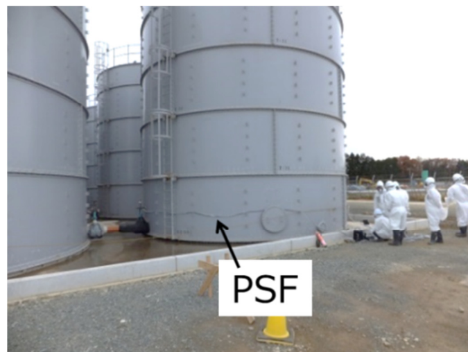
1Fにおける汚染水タンクの漏洩検知試験
