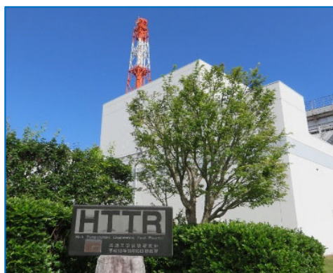
HTTR (高温工学試験研究炉)
