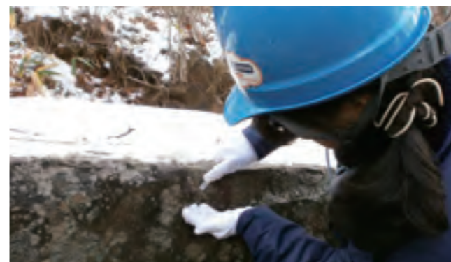
●地衣類 植物ではなく菌類と藻類の共生生物に分類される地衣類。地味だが黙々とヘラで地衣類を剥ぎ取る作業が続く。
