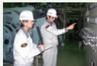
ディーゼル発電機周り点検
