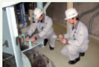
2次主循環ポンプ（A）周り弁点検
