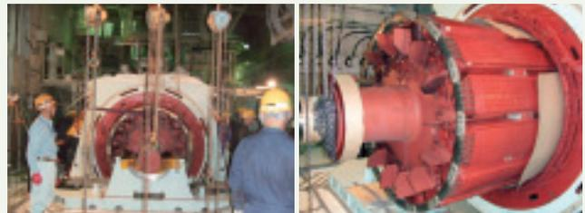
発電機ローター引抜き作業
