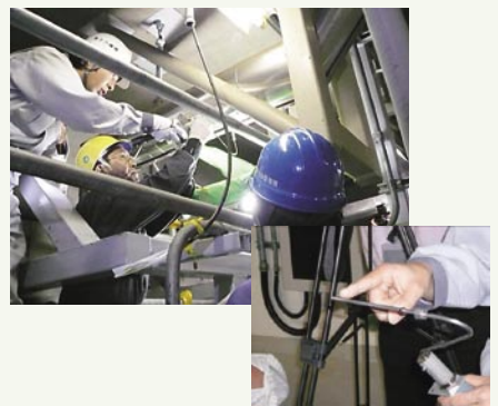
ナトリウム漏えい検出器の復旧作業(5月23日)
